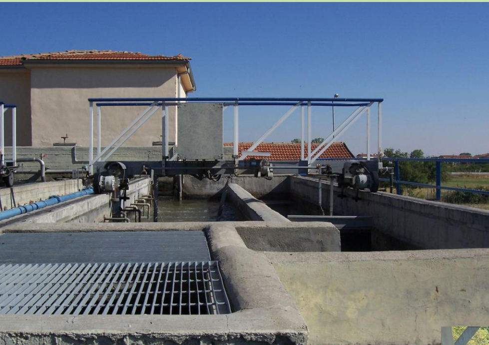
Αεριζόμενος αμμοσυλλέκτης (αριστερά) με λιποσυλλογή (δεξιά)
