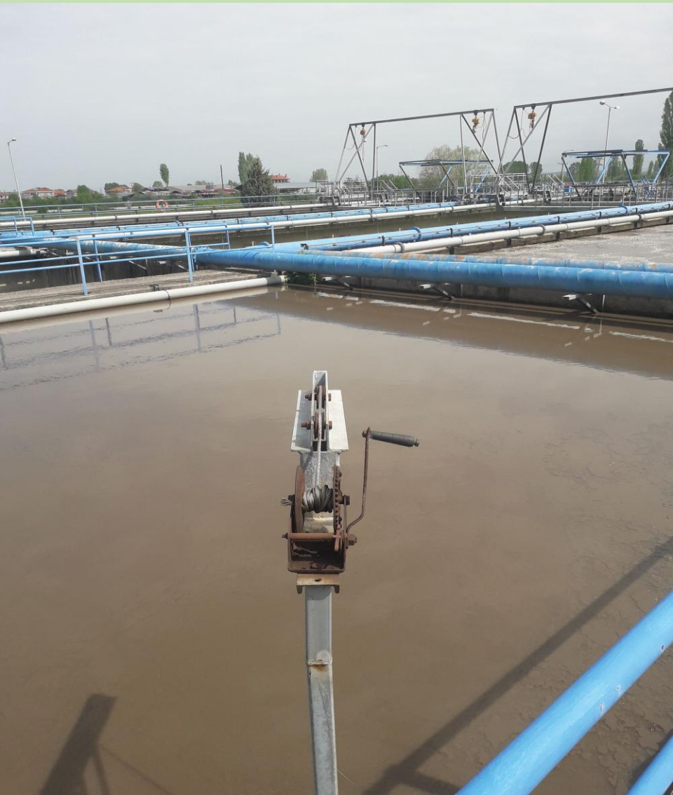
Δεξαμενή βιολογικής απομάκρυνσης φωσφόρου
