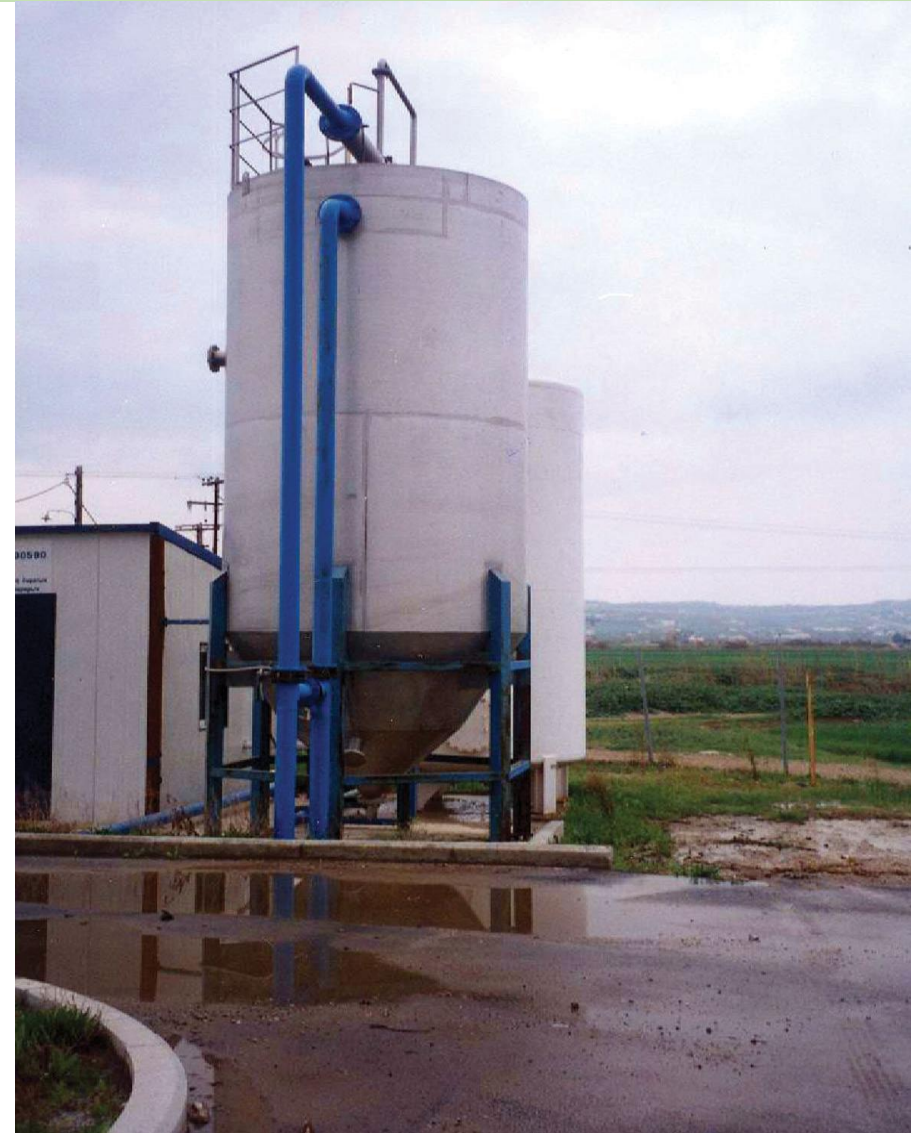
Συσκευή οζονισμού, ΜΕΛ Θεσσαλονίκης
