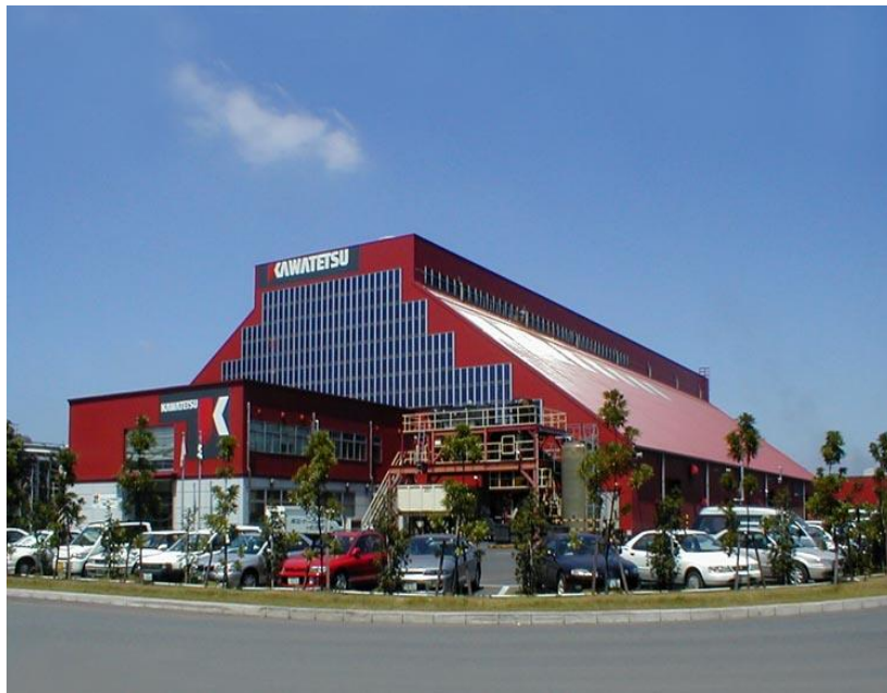
Εικόνα 1.15: MSW Gasification Plant, Chiba, Japan.
