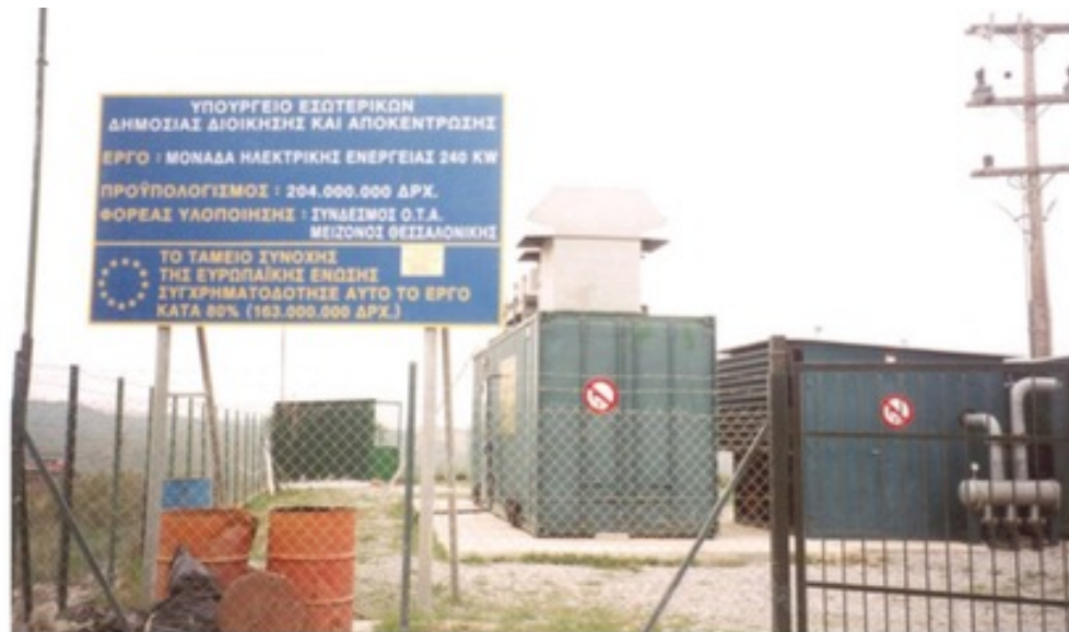
Σχήμα 10.17 Εγκαταστάσεις αξιοποίησης του βιοαερίου για παραγωγή ηλεκτρικής ενέργειας στο ΧΥΤΑ Ταγαράδων.
