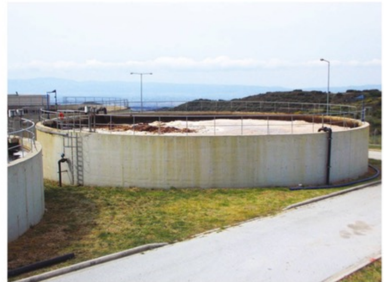
Σχήμα 10.14 Δεξαμενή αερόβιας επεξεργασίας διασταλαζόντων στο ΧΥΤΑ Μαυρο-ράχης Θεσσαλονίκης.
