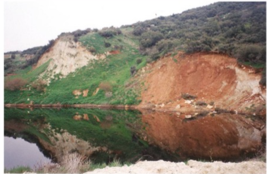
Σχήμα 10.16 Λιμνοδεξαμενή συλλογής διασταλαζόντων στο ΧΥΤΑ Ταγαράδων.
