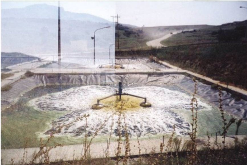
Σχήμα 10.13 Αερόβια επεξεργασία διασταλαζόντων στο ΧΥΤΑ Λάρισας.
