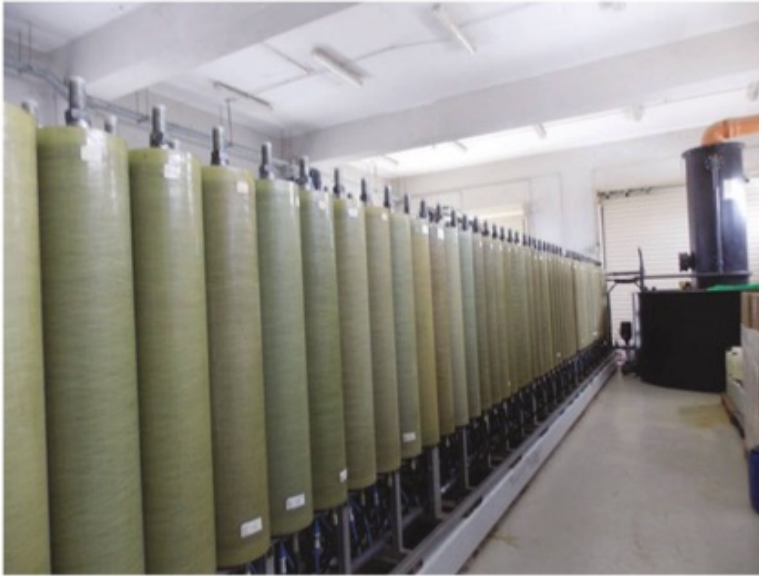
Σχήμα 10.15 Προχωρημένη επεξεργασία με αντίστροφη ώσμωση διασταλαζόντων στο ΧΥΤΑ Μαυροράχης.
