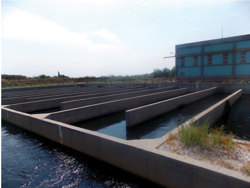
Χλωρίωση επεξεργασμένων υγρών αποβλήτων στην ΜΕΥΑ Θεσσαλονίκης
