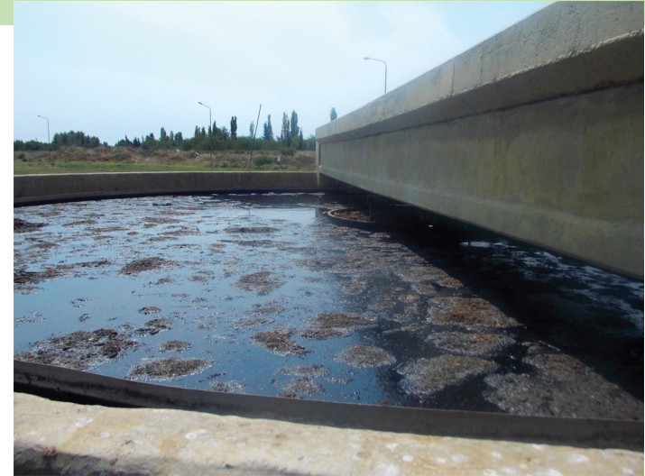
Δεξαμενή πάχυνσης ιλύος ΜΕΥΑ Θεσσαλονίκης
