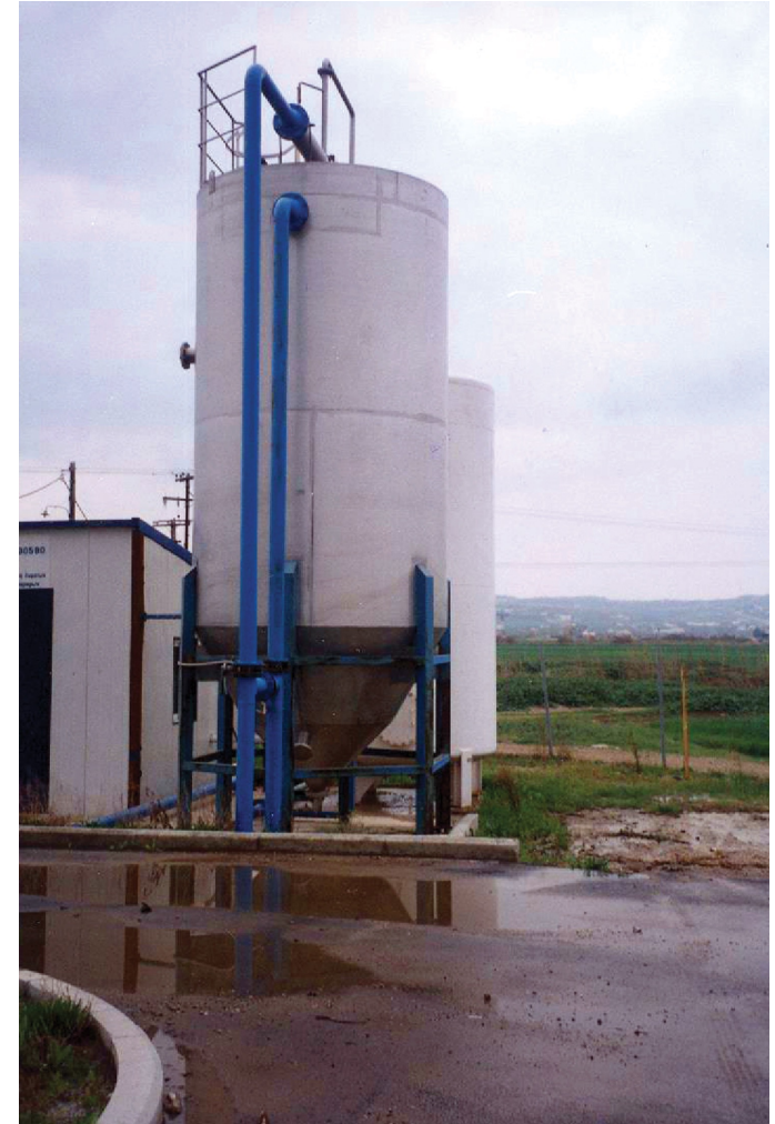
Συσκευή οζοντισμού ΜΕΥΑ Θέρμης, Θεσσαλονίκη
