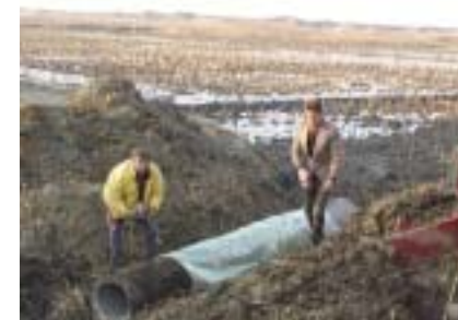
Τοποθέτηση σωληνών εισροής στο φίλτρο, Κατασκευή του φίλτρου χαλικιών στην έξοδο προς τη Βάσοβα
