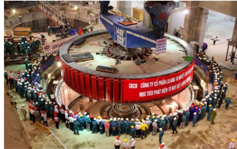
Εγκατάσταση δρομέα σύγχρονης μηχανής σε υδροηλεκτρικό εργοστάσιο [1]
