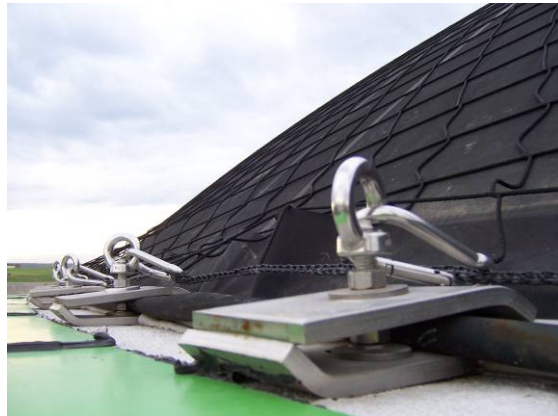
Σχήμα 7.24: Κάλυμμα χωνευτήρα από αεροστεγή μεμβράνη, όπως παρατηρείται από το εσωτερικό της δεξαμενής - αριστερά (AGRINZ, 2006), εφοδιασμένο εξωτερικά με πλέγμα διαστολής - δεξιά (RUTZ, 2006)
