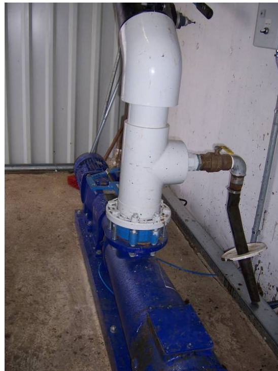
Σχήμα 7.8: Βαλβίδες διακοπής (αριστερά) και σύστημα άντλησης (δεξιά) (RUTZ, 2006)
