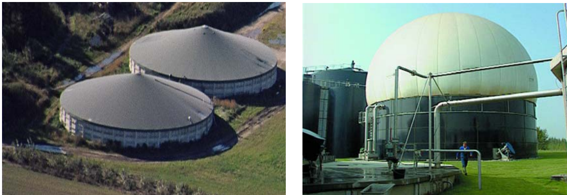
Σχήμα 7.32: Δεξαμενές αποθήκευσης καλυμμένες με μεμβράνες (Danish Biogas Association, 2008)
