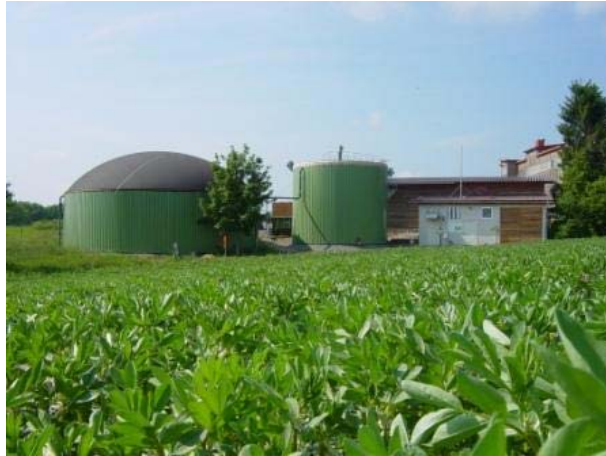
Σχήμα 4.6: Εγκατάσταση βιοαερίου στη Γερμανία, που επεξεργάζεται κοπριές από χοίρους, πουλερικά και σφρούς χόρτων (KRIEG AND FISHER, 2008)
