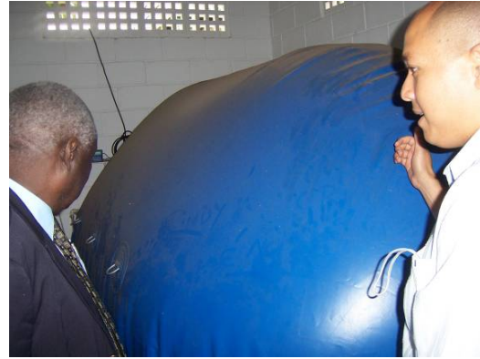
Σχήμα 7.23: Εξωτερικές δεξαμενές αποθήκευσης αερίου χαμηλής πίεσης (RUTZ, 2007)
