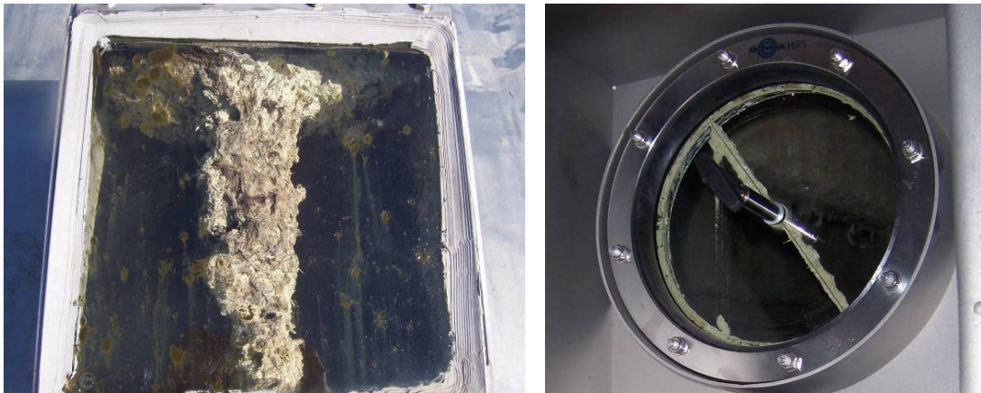
Σχήμα 7.26: Στοιχειακό θείο, που προκύπτει από βιολογική αποθείωση μέσα στο χωνευτήρα (RUTZ, 2007)
