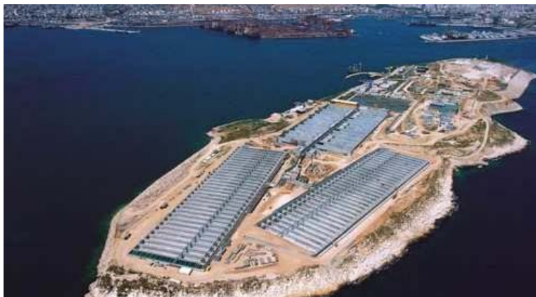
Σχήμα 4.11: Μονάδα επεξεργασίας υγρών αποβλήτων στην Ψυτάλλεια, Ελλάδα (ΕΥΛΑΠ, 2004)
