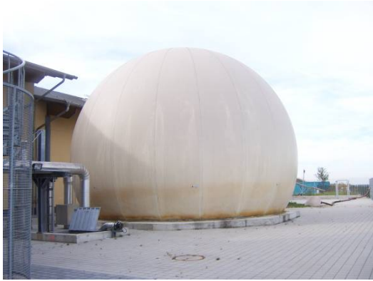
Σχήμα 7.23: Εξωτερικές δεξαμενές αποθήκευσης αερίου χαμηλής πίεσης (RUTZ, 2007)
