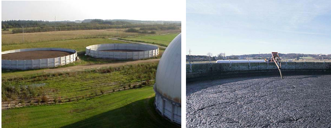
Σχήμα 7.31: Δεξαμενές αποθήκευσης με φυσικό επιπλέον στρώμα (AL SEADI, 2008)
