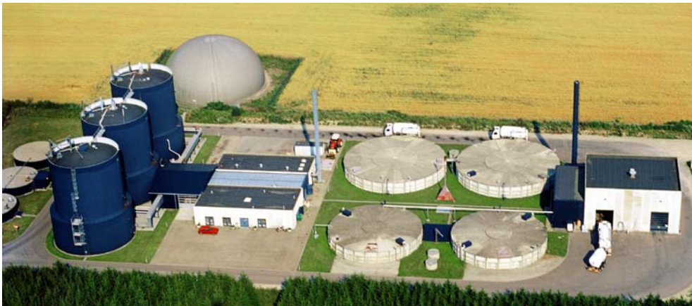
Σχήμα 4.8: Εικόνα μιας εγκατάστασης συγχώνευσης από τη Δανία (LEMVIG BIOGAS)
