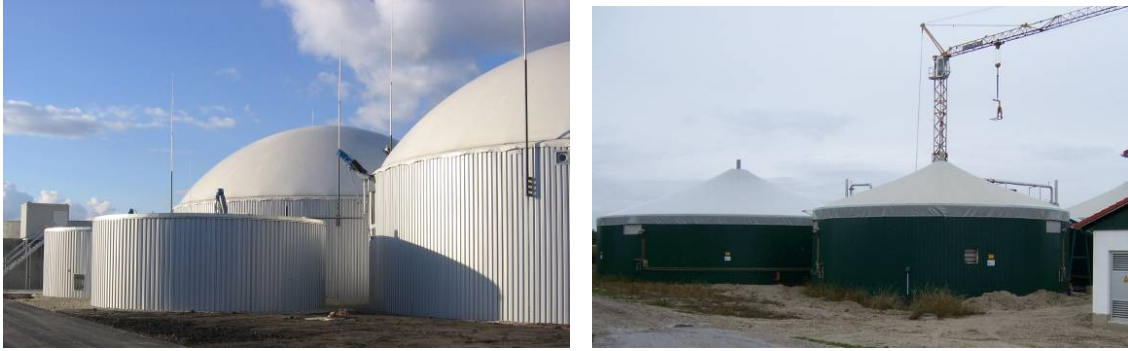
Σχήμα 7.20: Κατακόρυφοι χωνευτήρες καλυμμένοι από αεροστεγείς μεμβράνες. Η μεμβράνη διογκώνεται από το παραγόμενο βιοαέριο – αριστερά (AGRINZ GmbH, 2008) – Η μεμβράνη είναι στερεωμένη σε έναν κεντρικό ιστό – δεξιά (RUTZ, 2006-δεξιά)
