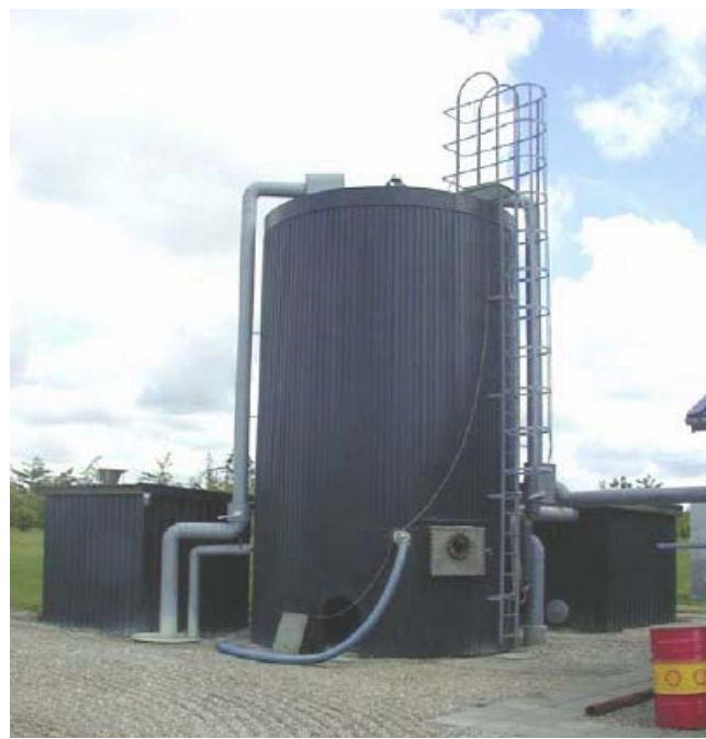
Σχήμα 7.30: Δεξαμενή αντιδραστήρα για την αφαίρεση του υδρόθειου (ANGELIDAKI, 2005)
