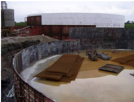
Σχήμα 7.19: Επιτόπου κατασκευή κατακόρυφων χωνευτήρων φτιαγμένων από σκυρόδεμα (RUTZ, 2007)
