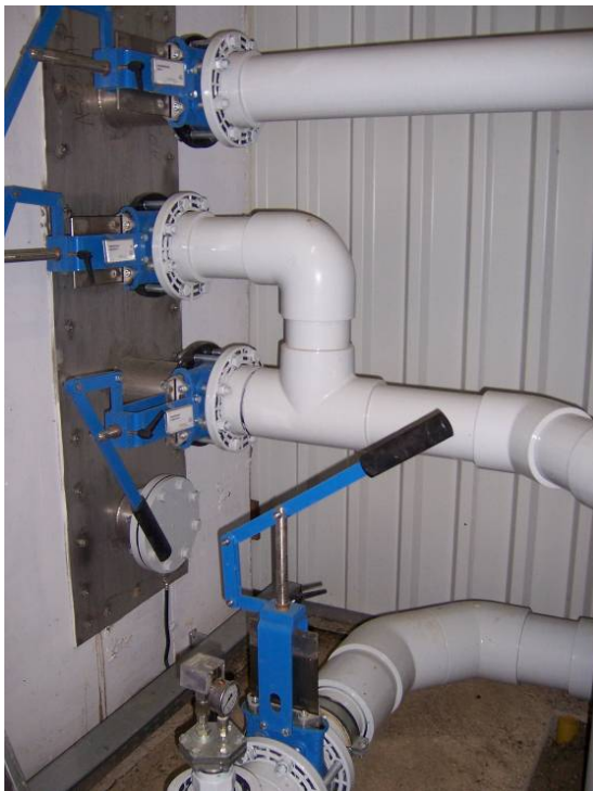
Σχήμα 7.8: Βαλβίδες διακοπής (αριστερά) και σύστημα άντλησης (δεξιά) (RUTZ, 2006)
