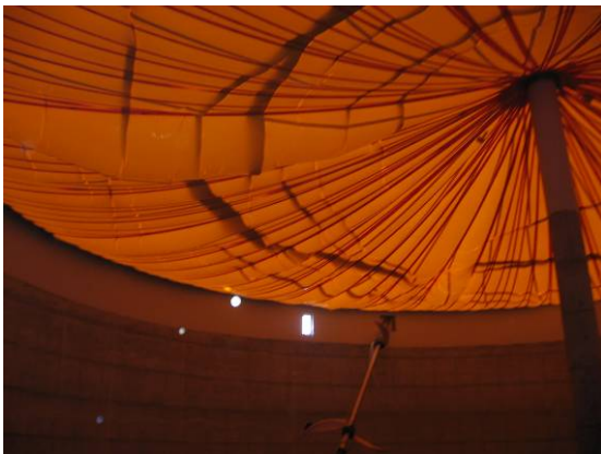
Σχήμα 7.24: Κάλυμμα χωνευτήρα από αεροστεγή μεμβράνη, όπως παρατηρείται από το εσωτερικό της δεξαμενής - αριστερά (AGRINZ, 2006), εφοδιασμένο εξωτερικά με πλέγμα διαστολής - δεξιά (RUTZ, 2006)
