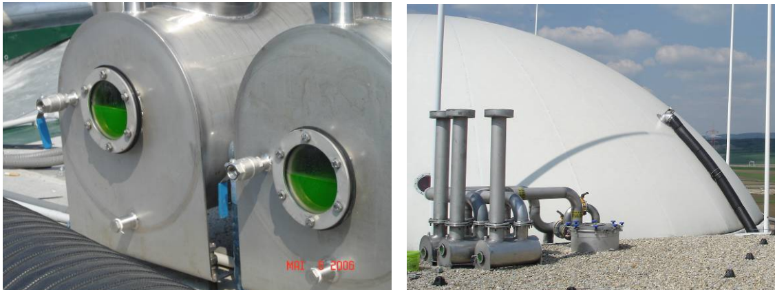
Σχήμα 7.22: Εγκαταστάσεις πίεσης και βαλβίδες ασφαλείας (AGRINZ, 2006)
