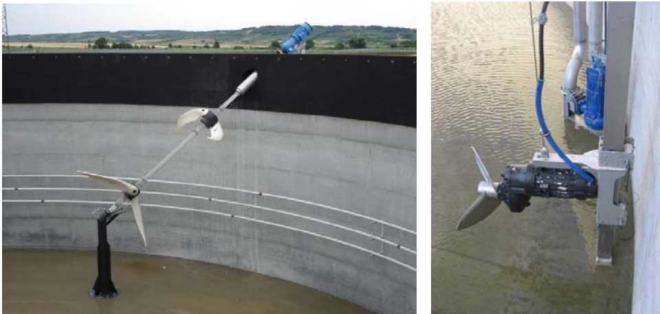
Σχήμα 7.23: Αναδευτήρες πτερυγίων (αριστερά) και αναδευτήρας έλικας με καταδύόμενο κινητήρα (δεξιά) (AGRINZ GmbH, 2006)
