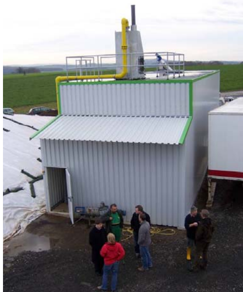
Σχήμα 7.20: Οριζόντιος χωνευτήρας στρωτής ροής (RUTZ, 2006)
