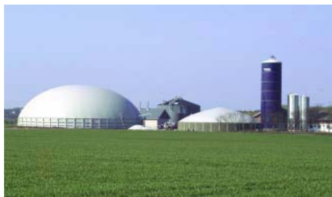
Σχήμα 4.5: Εγκατάσταση βιοαερίου κλίμακας αγροκτήματος στη Δανία, για συγχώνευση ζωικών πολτών και ενεργειακών καλλιεργειών (GROENGAS A/S)
