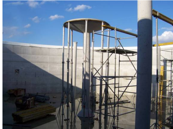
Σχήμα 7.19: Επιτόπου κατασκευή κατακόρυφων χωνευτήρων φτιαγμένων από σκυρόδεμα (RUTZ, 2007)
