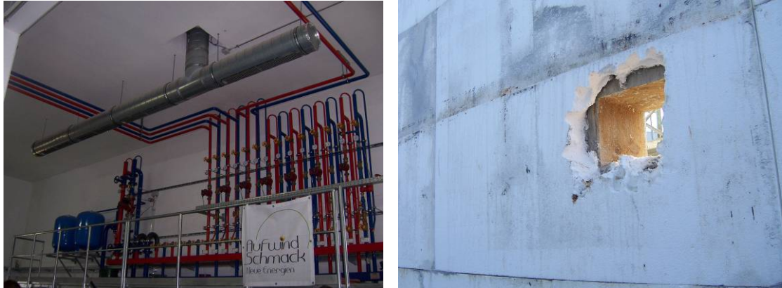
Σχήμα 7.16: Σύστημα θέρμανσης μιας εγκατάστασης βιοαερίου (αριστερά) και μόνωση ενός τοιμεντένιου χωνευτήρα που είναι υπό κατασκευή (δεξιά) (RUTZ, 2008)
