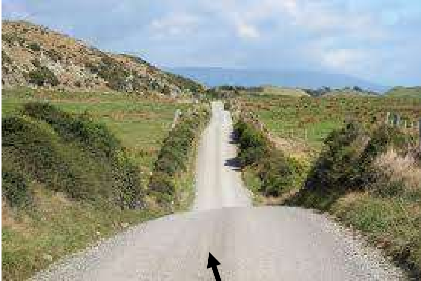
Επιφανειακή στρώση από ασύνδετο υλικό (αμμοχάλικο) – Unpaved roads
