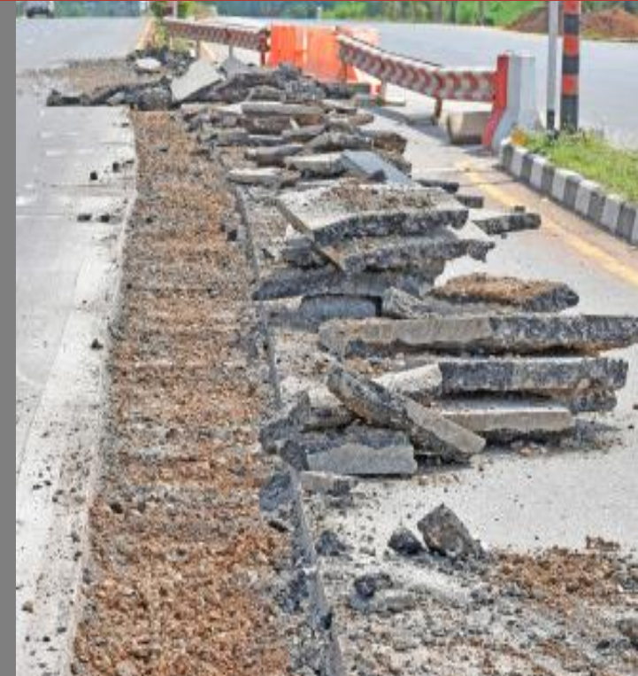
Ανάκτηση υλικών από παλιό οδόστρωμα
