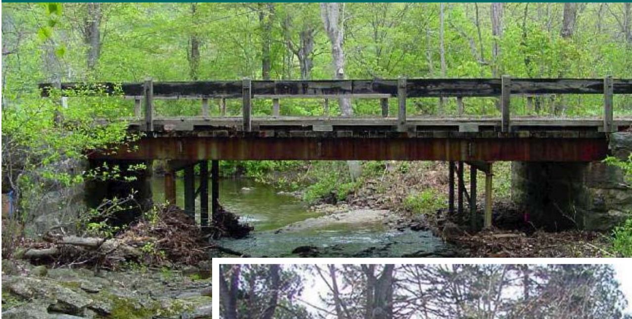
Μεταλλική γέφυρα ανοίγματος 9μ, Βιρτζίνια (έτος κατασκευής 1930)
