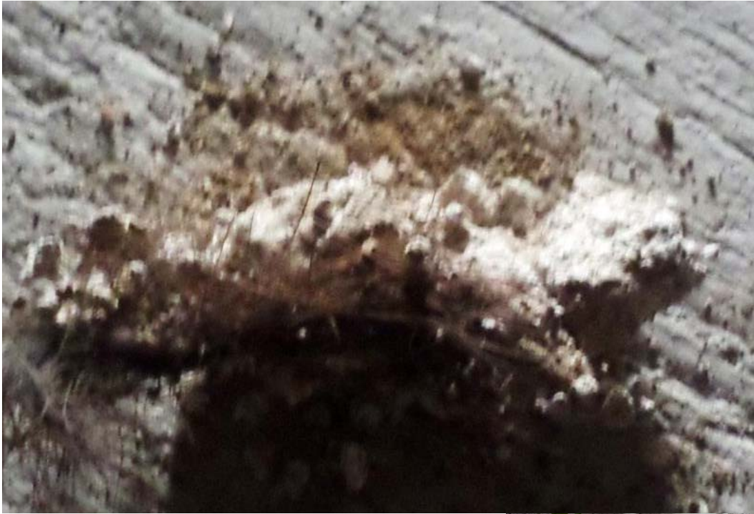
Παραδοσιακό ασβεστοκονίαμα με ζωικό μαλλί – Καπναποθήκη Ξάνθης
