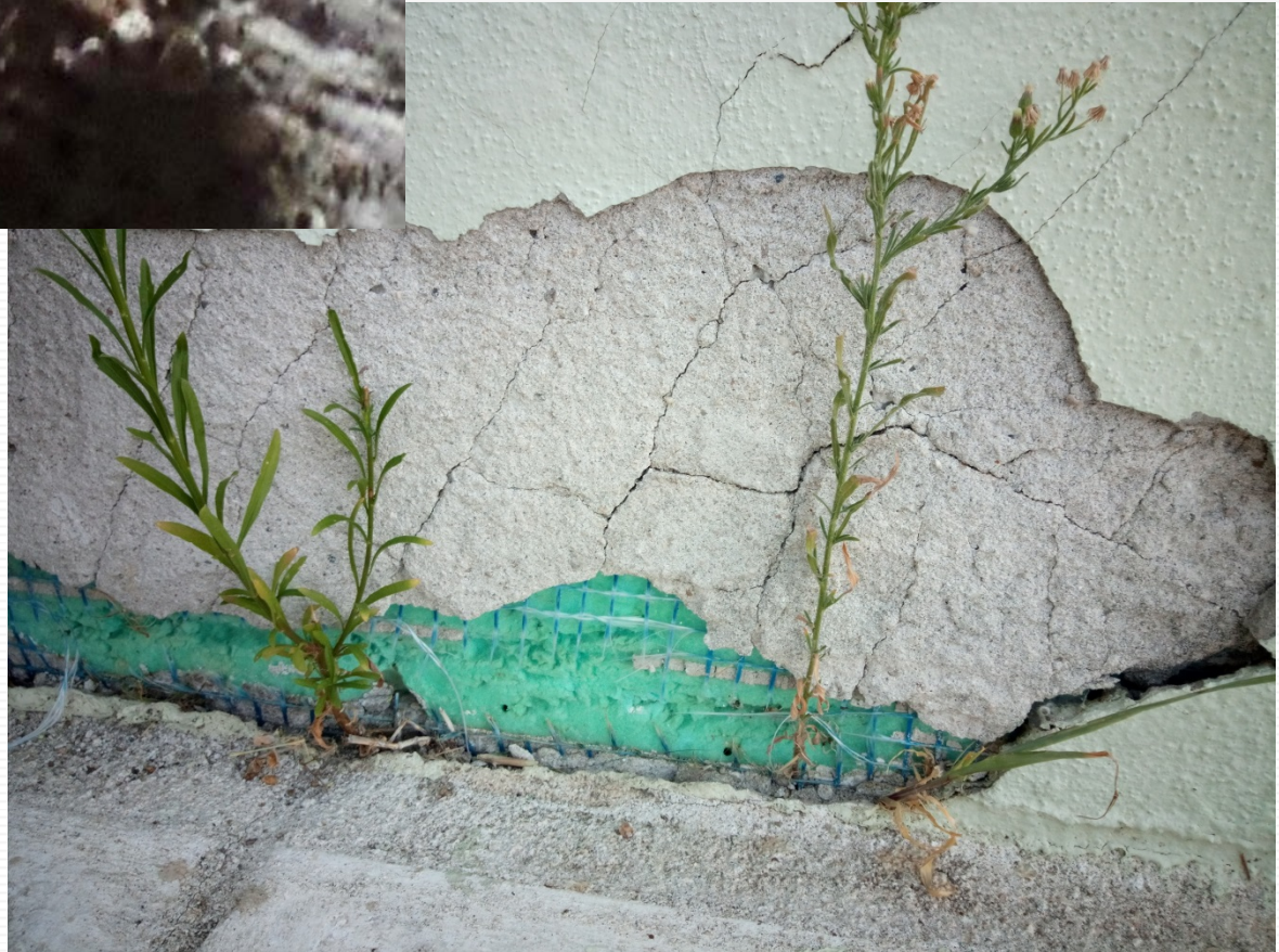
Παραδοσιακό ασβεστοκονίαμα με ζωικό μαλλί – Καπναποθήκη Ξάνθης
