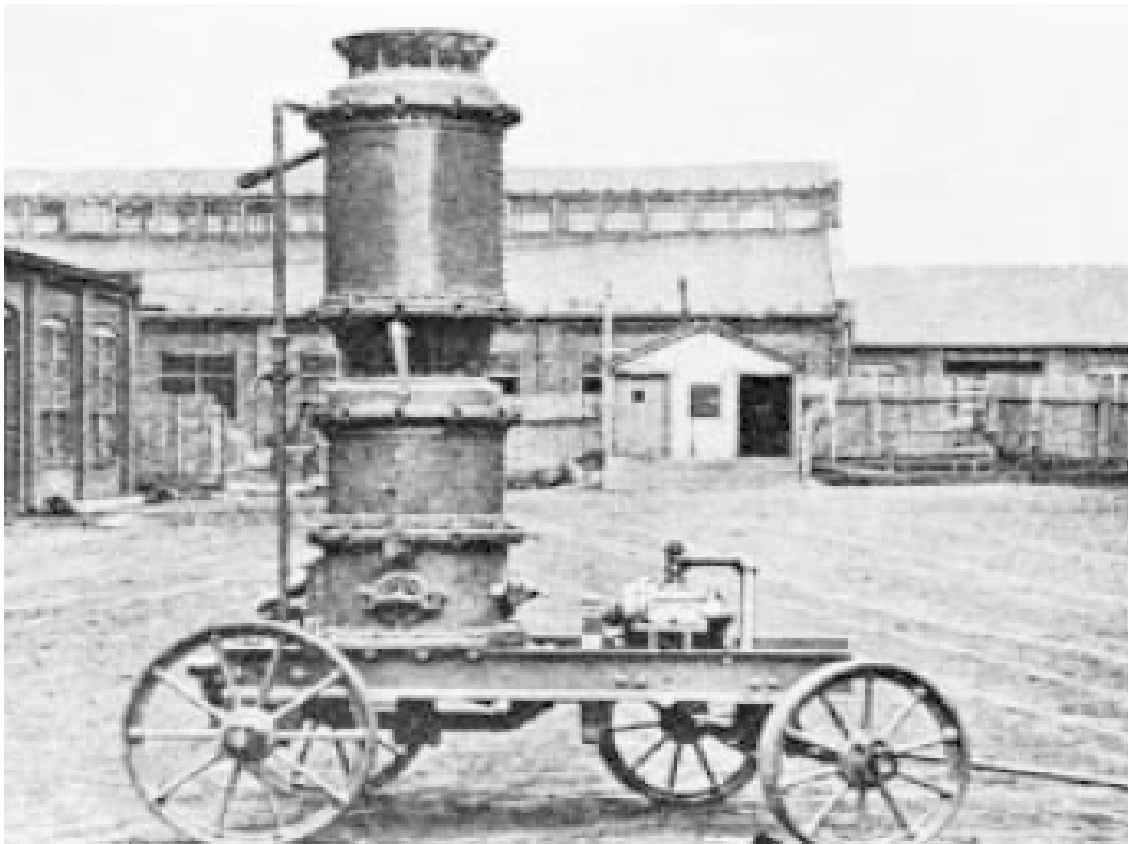
Εικόνα 1: Η πρώτη μηχανή εκτοξευόμενου Σκυροδέματος που χρησιμοποιήθηκε από τον Carl Akeley το 1907 (φώτο του J.J. Shideler, Portland Cement Association), [14]
