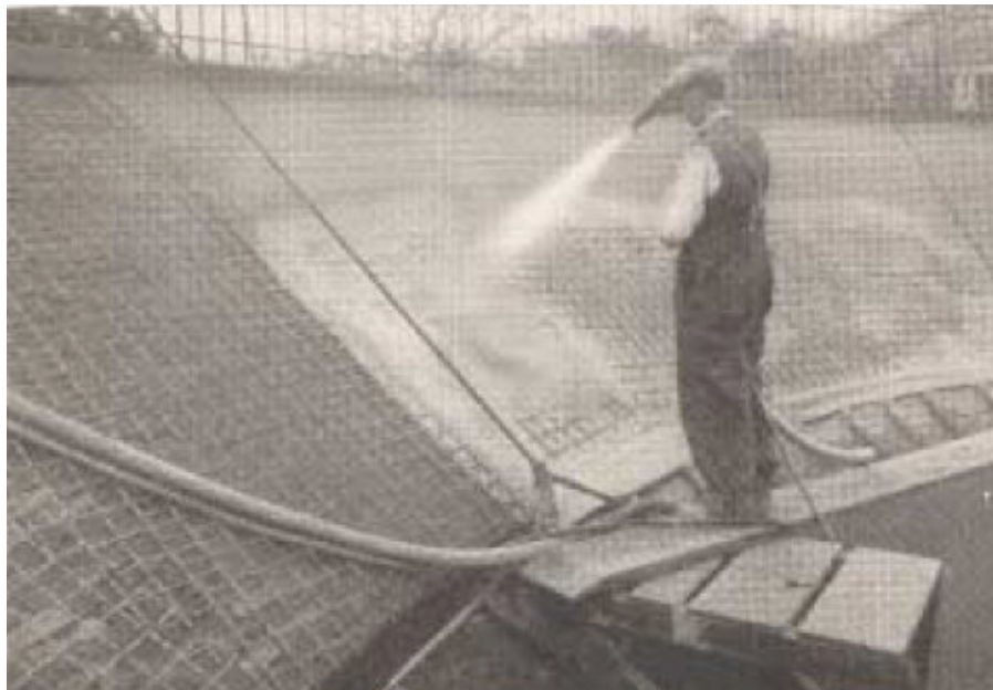
Εικόνα 4: Εκτόξευση σκυροδέματος το 1919 για κατασκευή δεξαμενής νερού [17].
