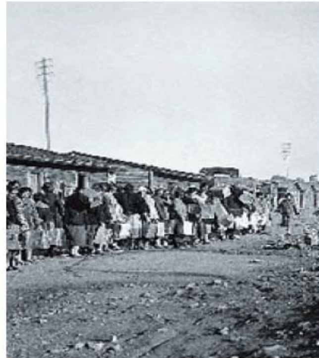
Υδροληψία σε γειτονιά της Αθήνας (1933)
