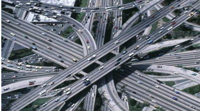
Σχήμα 4. Εξάωροφος (!) ανισόπεδος κόμβος αυτοκινητοδρόμων
