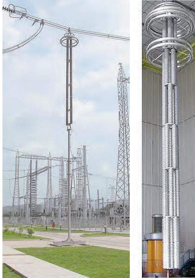
Σχήμα 7.20: Εκτροπείς υπερτάσεων HVDC 500kV (αριστερά) και 1100kV (δεξιά) [15]
