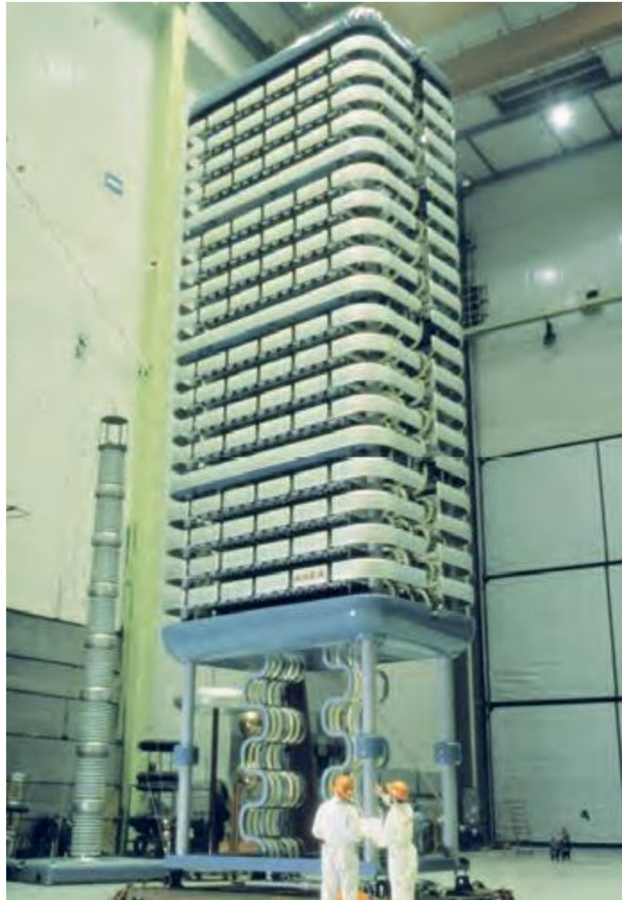
Σχήμα 7.15: Μέρος ενός μετατροπέα ισχύος HVDC σε διαδικασία δοκιμών [15]
