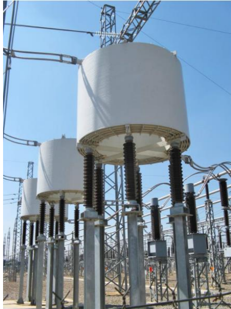
Σχήμα 7.19: Αυτεπαγωγή εξομάλυνσης [18].
