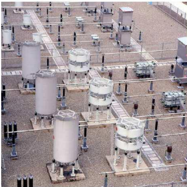
Σχήμα 7.16: AC φίλτρα [16]
