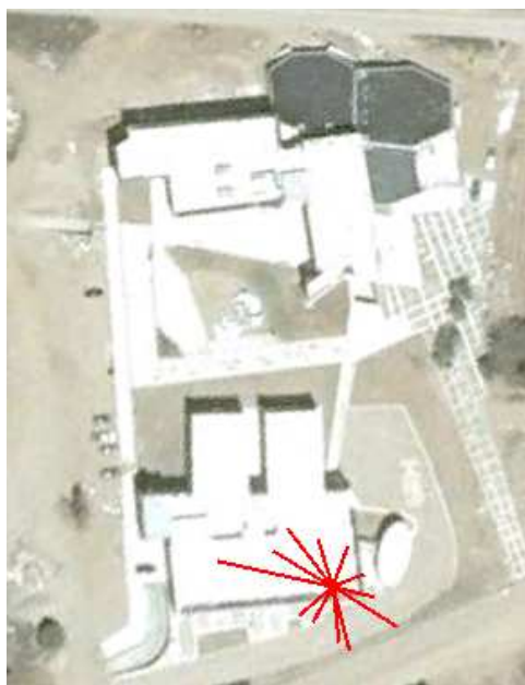
Εικόνα 5.2 Διευθύνσεις που ελέγχθηκαν στην οροφή του κτηρίου Ηλεκτρολόγων Μηχ. και Μηχ. Η/Υ
