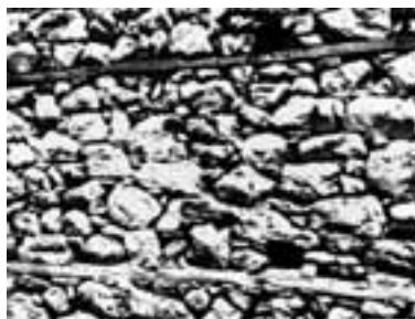
φωτογραφία 7: Λεπτομέρεια στη δομή του τοίχου με την παρεμβολή ξύλινων διαζωμάτων ανά ορισμένο ύψος
