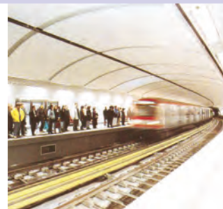
φωτ. 13.9 Το Αττικό Μετρό στην Αθήνα. Το Ευρωπαϊκό Κοινοβούλιο συγχρηματοδότησε την κατασκευή του ( www.metro.gr ).
