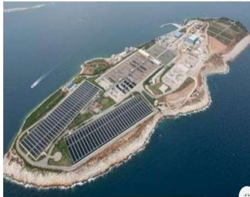
Εγκατάσταση Επεξεργασίας Λυμάτων στην Ψυττάλεια (πηγή: http://www.ypeka.gr ).
