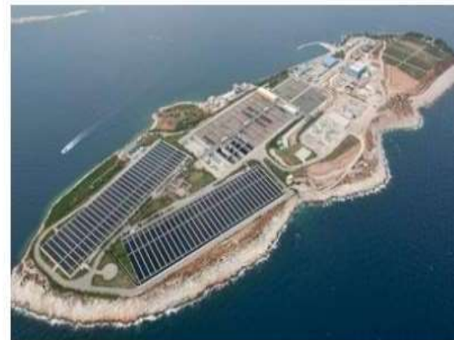
Εγκατάσταση Επεξεργασίας Λυμάτων στην Ψυττάλεια (πηγή: http://www.ypeka.gr ).
