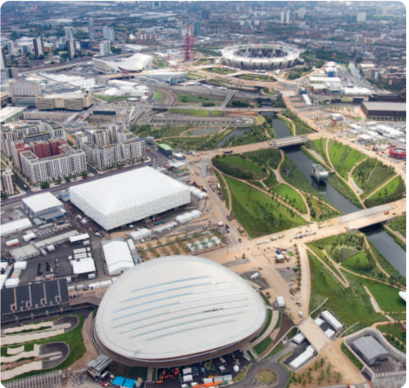
Λονδίνο 2012: Εναέρια λήψη του Ολυμπιακού Πάρκου.
