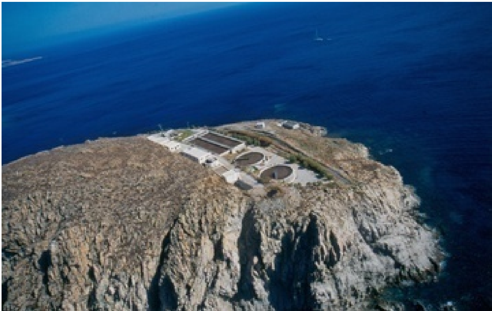
Σχ. 106. Εγκατάσταση Βιολογικού καθαρισμού στη Μύκονο.
