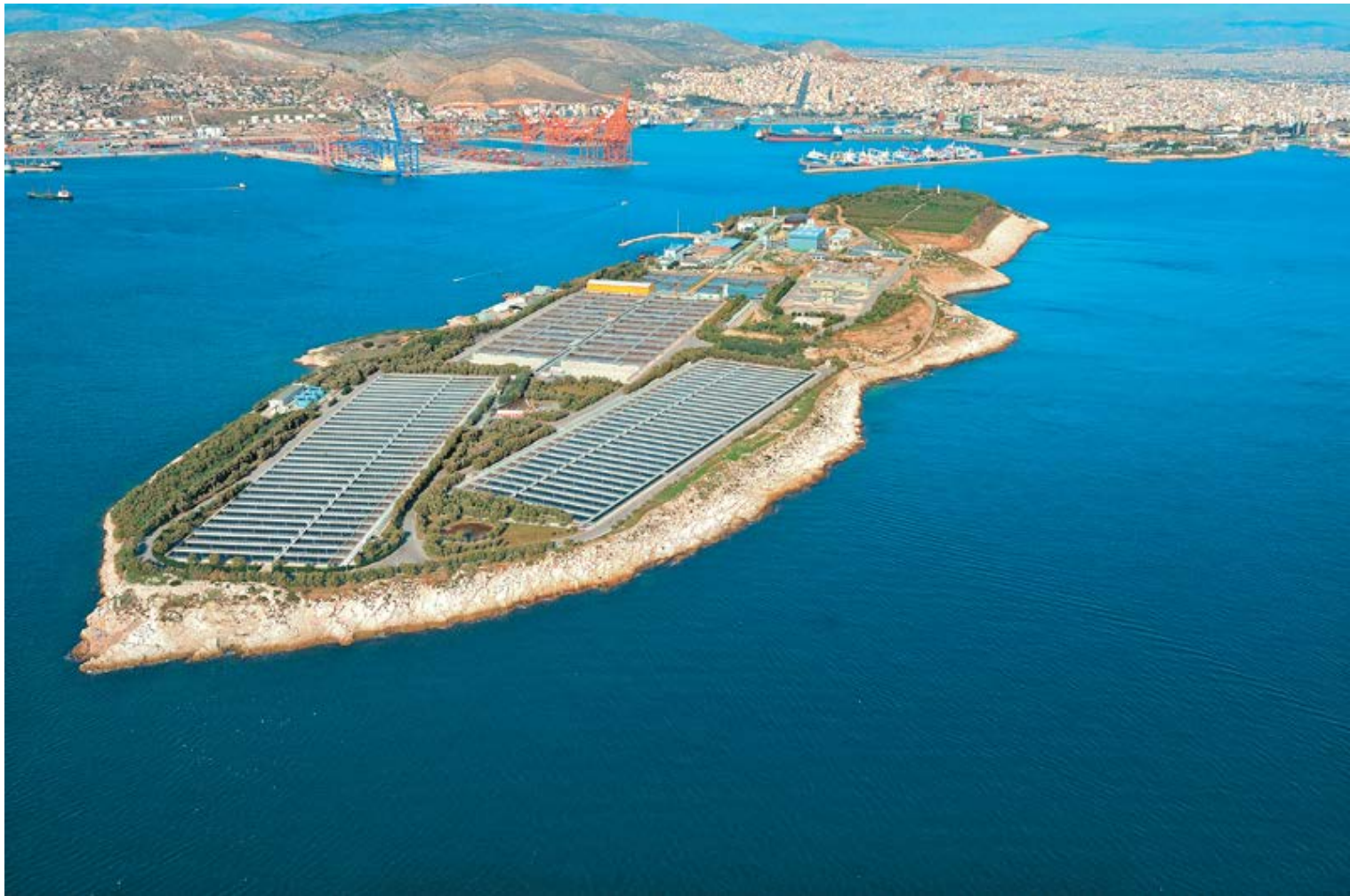
Σχ. 112. Βιολογικός καθαρισμός Ψυτάλλειας.
