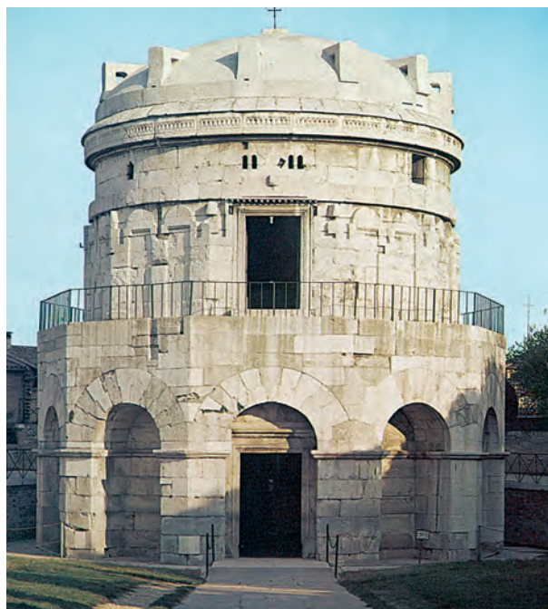
Το Μουσολείο του βασιλιά Θεοδέριχου στη Ραβέννα (μετά το 526). Πρόκειται για διώροφο κτίσμα που σκεπάζεται από μονόλιθη λαξευτή πέτρα βάρους 170 τόνων διακοσμημένο με λαβές και γεωμετρική ταινία.
