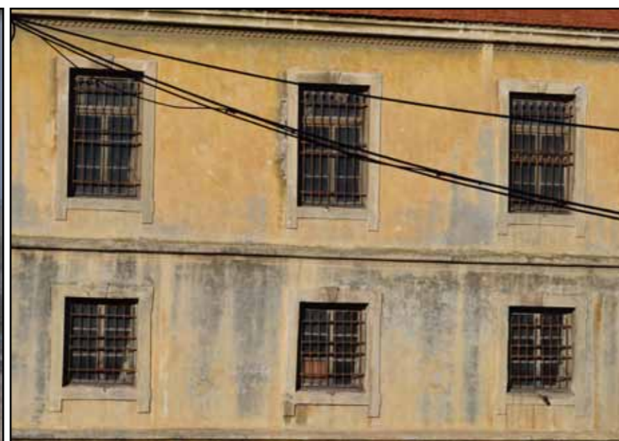
Παράθυρα στη νότια όψη
