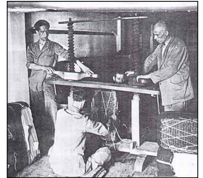
Χειροκίνητη μηχανή για να πάρει η τούγκα διαστάσεις εξαγωγής [Μέγκενι]
