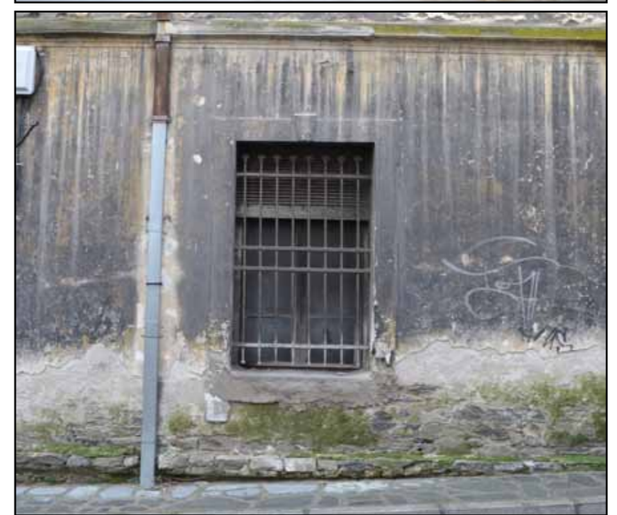
_Άνοιγματα στην οροφή του δευτέρου και πρώτου ορόφου κατά τη φάση του εκσυγχρονισμού και της εισαγωγής των μηχανημάτων στο κτίριο προς εξυπηρέτηση της διαδικασίας. _Τα ρολά στα ανοίγματα του ισογείου.[βόρεια όψη]
