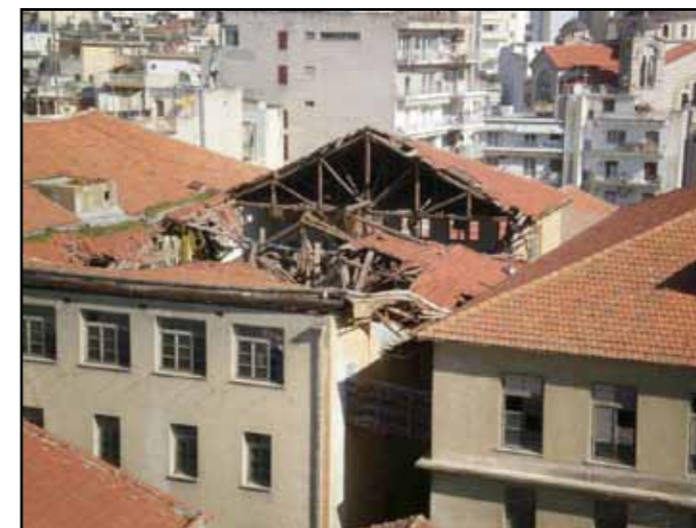
Καπναποθήκες ΣΕΚΕ - στέγη σε μοντέρνα κατασκευή
