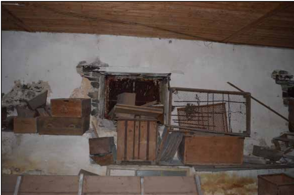
Τα ίχνη των ανοίγματος στο υπόγειο που έκλεισαν [εσωτερικά]
