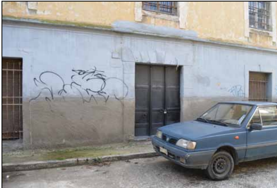
_Επεμβάσεις στο ισόγειο τμήμα της δυτικής όψης _Επεμβάσεις - ανακατασκευή τμήματος της νότιας όψης
