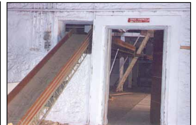
Ανοίγματα για τη συνέχιση των ταινιών
