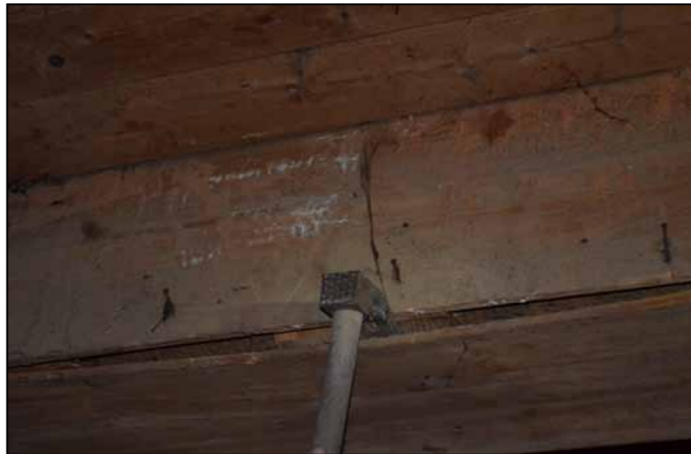
Ξύλινη επένδυση δοκών
