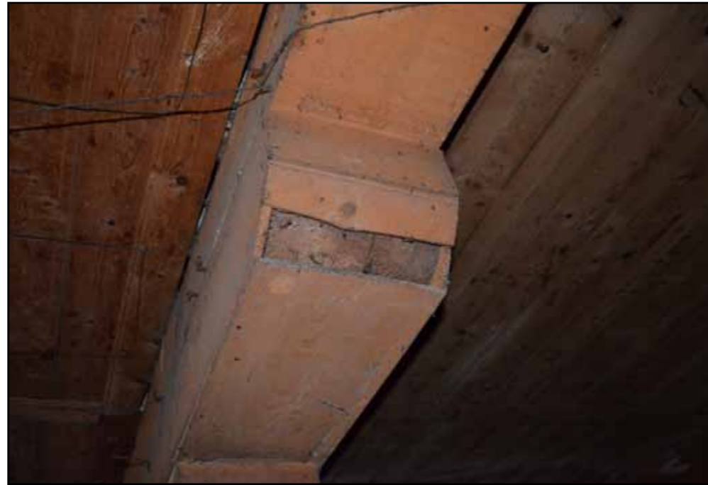
Ξύλινη επένδυση μαξιλαριών υπογείου
