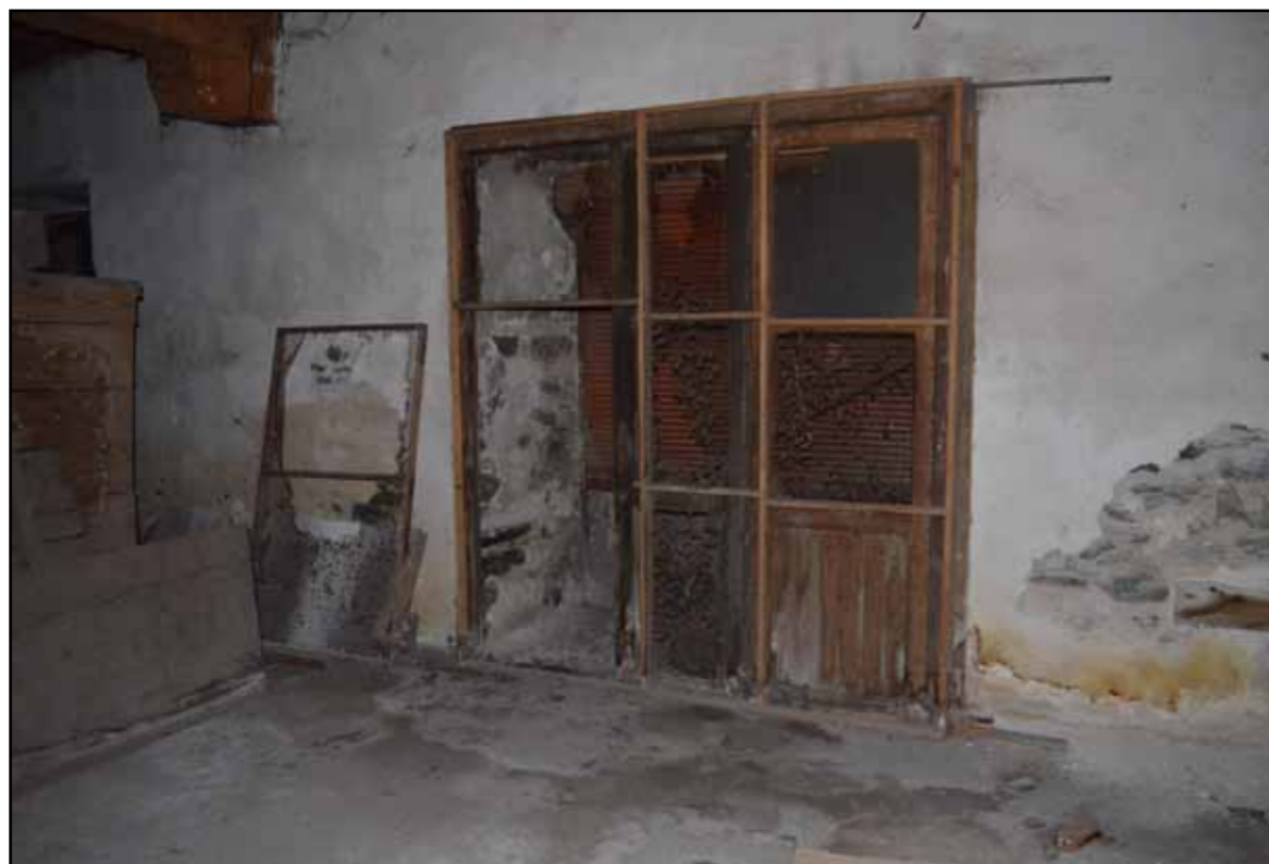
Κλείσιμο ανοιγμάτων της ανατολικής όψης με την αλλαγή της στάθμης του εδάφους
