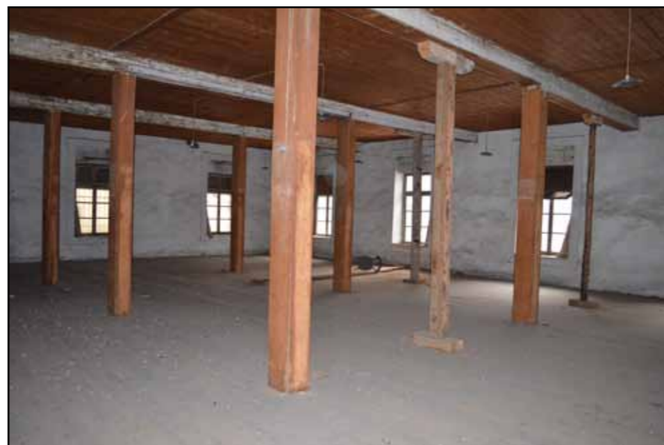
_Σκάλα υπογείου νότιου τμήματος _Πρόχειρη υποστήλωση δοκών στο ισόγειο
