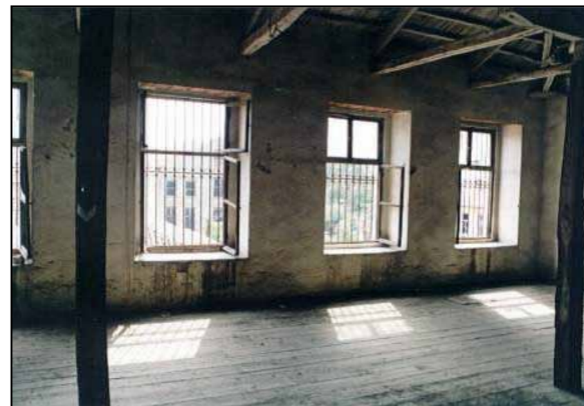
Οι όψεις των καπναποθηκών διαμορφώνονται με συμμετρικά ανοίγματα που εξασφαλίζουν τον απαραίτητο για την εργασία φωτισμό στο εσωτερικό
