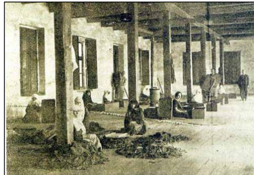
Ξεφύλλισμα στους χώρους επεξεργασίας: μεγάλοι – ευρύχωροι, ενιαίοι χώροι. Η οργάνωση των όψεων με πολλά και εκτεταμένα συμμετρικά ανοίγματα εξασφαλίζει ομοιόμορφο και ικανοποιητικό φωτισμό. Η εργασία πραγματοποιείται πλησίον των παραθύρων
