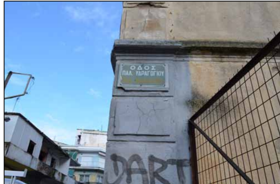
_Βλάστηση στη βάση της νότιας όψης και στον τοίχο αντιστήριξης _Επεμβάσεις στη νότια όψη
