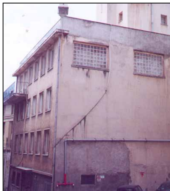
Καπναποθήκη στην οδό Δαγκλή. Φέρουσα κατασκευή από οπλισμένο σκυρόδεμα, τα ανοίγματα μορφώνονται με υαλότουβλο
