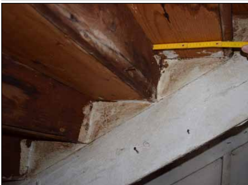
Κλιμακοστάσιο 2ου ορόφου
