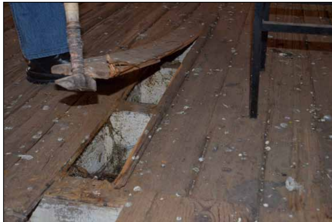
Δάπεδο ισόγειου - σανίδωμα και δοκίδες
