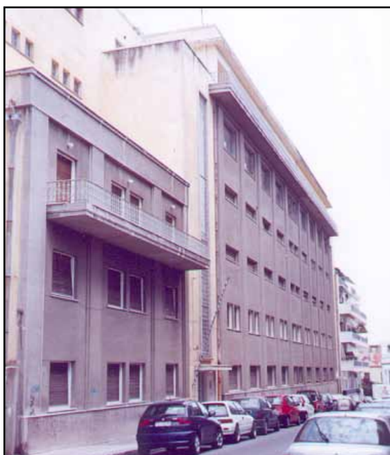
Καπναποθήκη στην οδό Παλαιολόγου. Φέρουσα κατασκευή από οπλισμένο σκυρόδεμα
