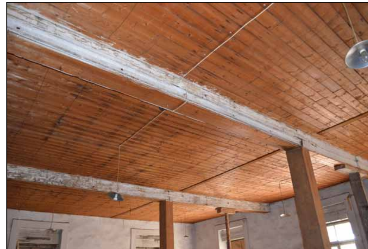
Οροφή χώρου εργασίας [ισόγειο]
