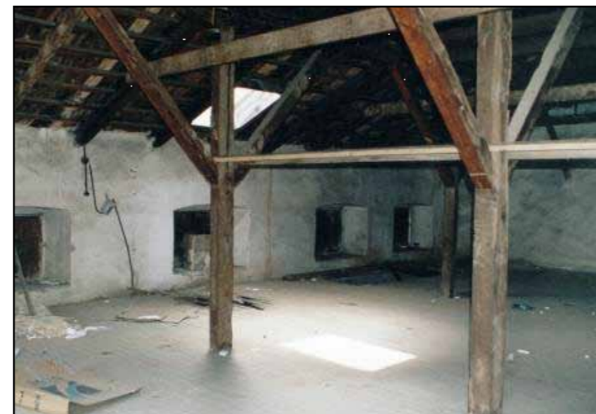
Οι φεγγίτες της στέγης ενισχύουν τον φωτισμό στο εσωτερικό
