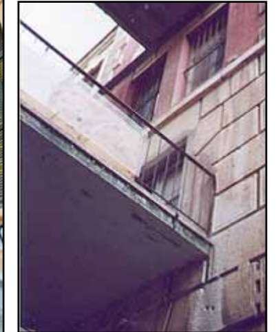
Γέφυρες από μέταλλο ή από οπλισμένο σκυρόδεμα, συνδέουν κτίρια που είναι σε γειτνίαση
