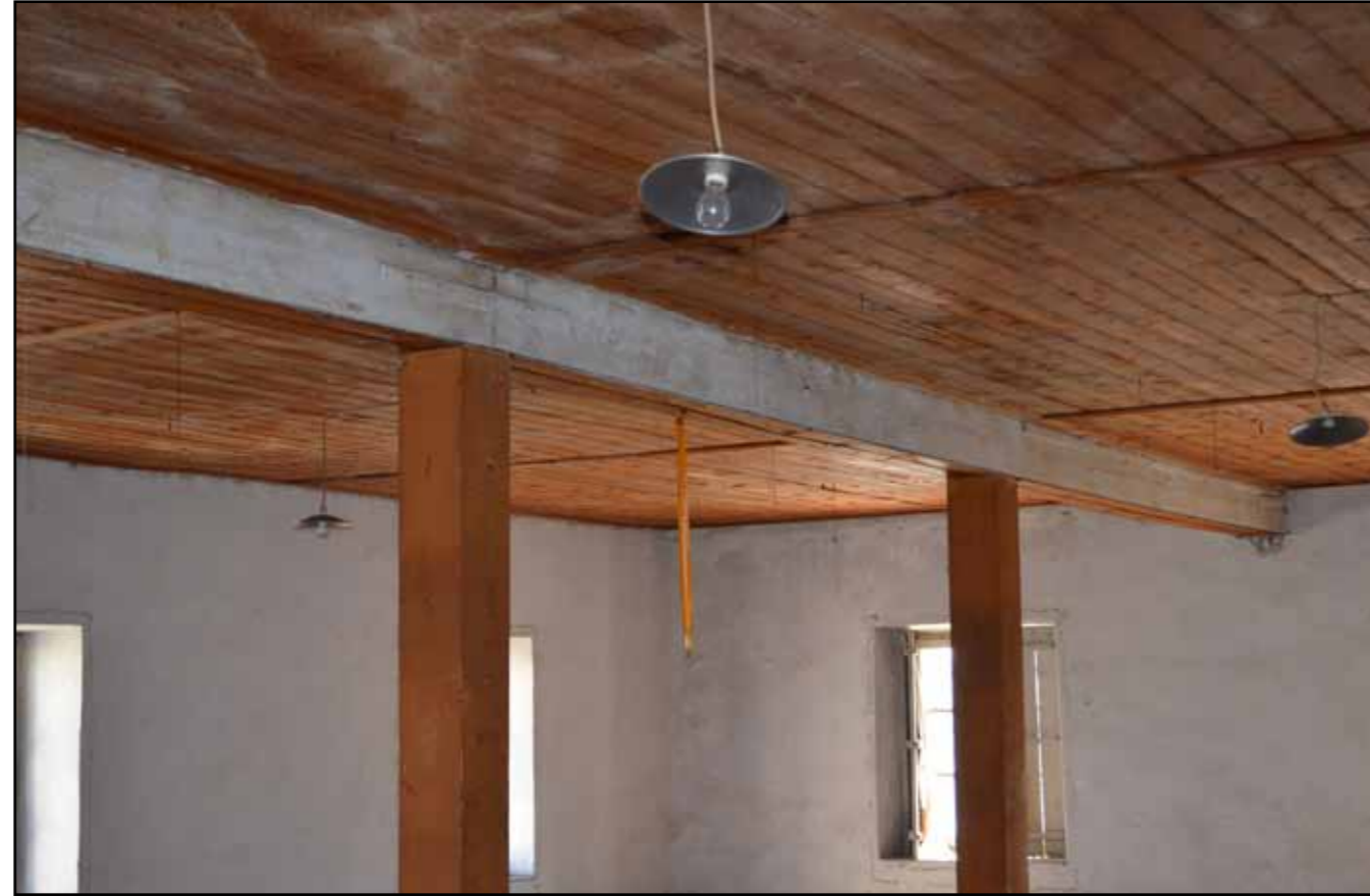
Επενδυμένοι στύλοι και δοκοί. Ένωση δοκών πάνω στον στύλο με μεταλλική λάμα.
