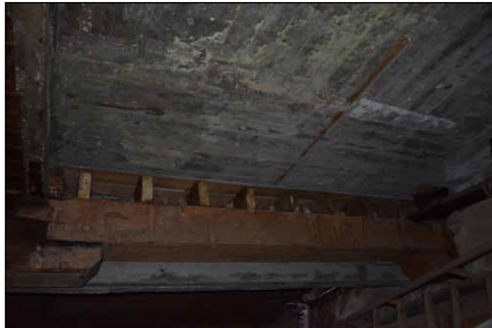
_Πλάκα από βετον και αποχετεύσεις [υπόγειο] _Κόψιμο των δοκίδων του πατώματος του ισόγειου για την κατασκευή των wc
