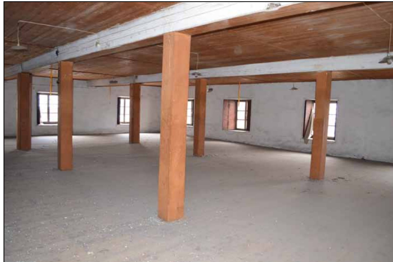
Επενδυμένοι στύλοι και δοκοί. Ένωση δοκών πάνω στον στύλο με μεταλλική λάμα.
