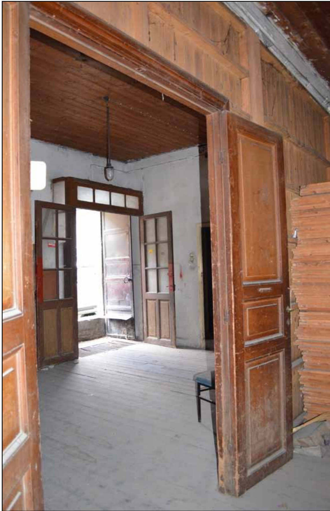
Οι ξύλινες επενδύσεις στο χώρο εισόδου
