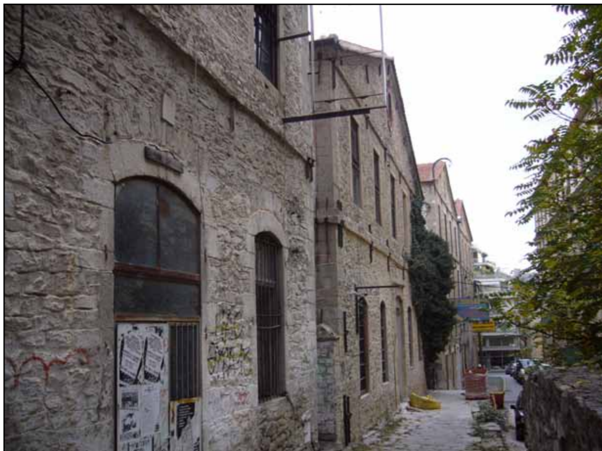
Φέρουσα κατασκευή από πέτρα
