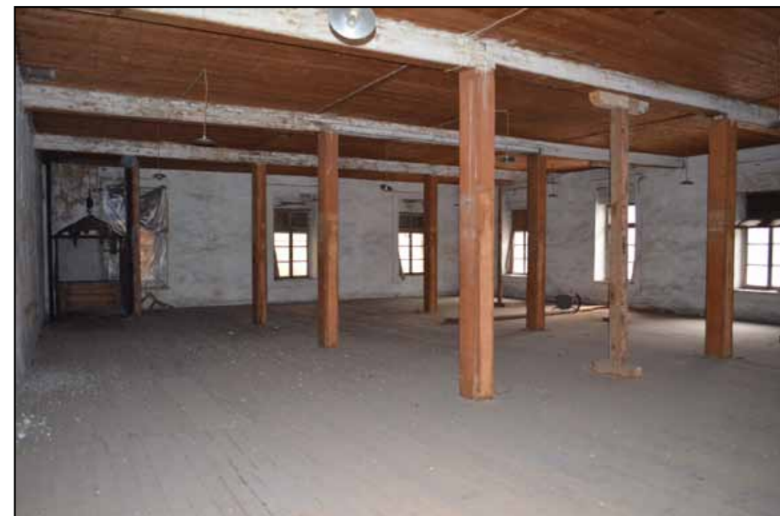
Διάταξη δοκών στο ισογείο
