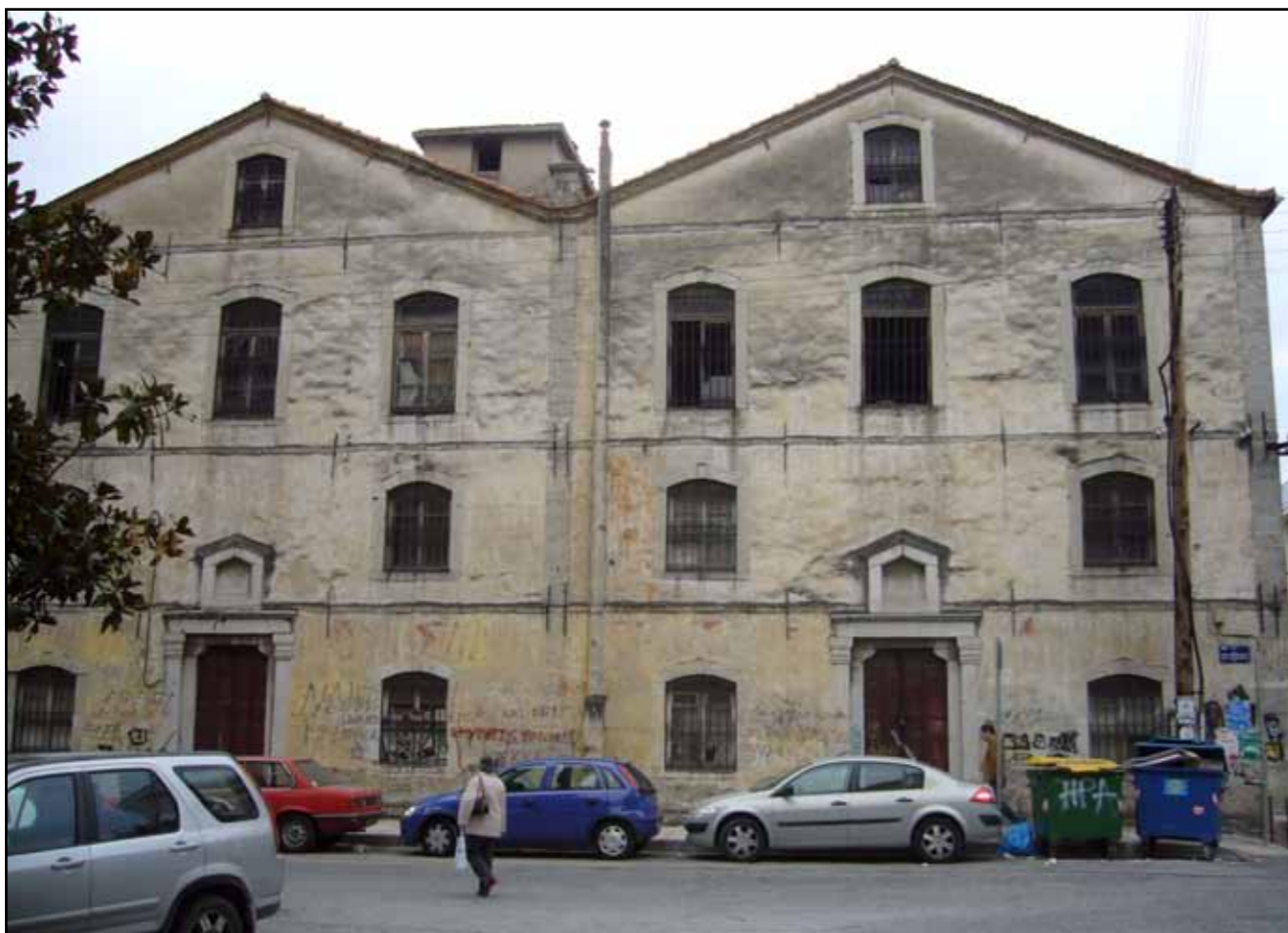
Τα ανοίγματα στο ισόγειο είναι λίγο μικρότερα από αυτά των υπερκείμενων ορόφων και στο μεσοπάτωμα ή πρώτο όροφο, αντιστοίχως μικρότερων διαστάσεων των παραθύρων των ανώτερων επιπέδων
