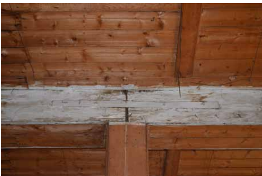
Ένωση δοκών με μεταλλικές λάμες
