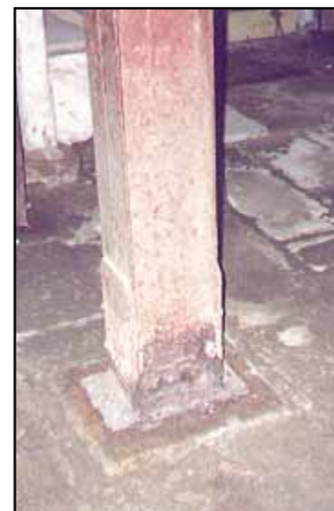
Μεταλλικό υποστύλωμα διπλού U
