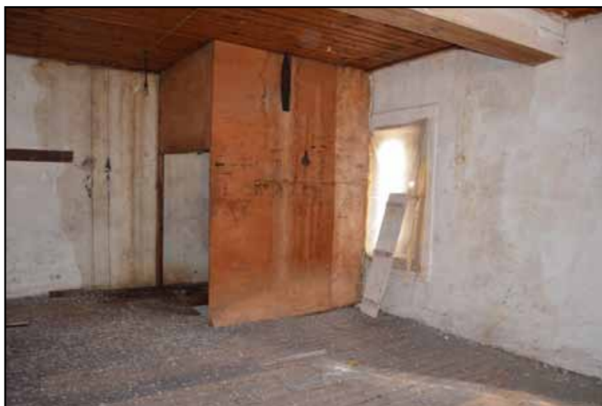
Διαμόρφωση χώρου για ανελκυστήρα [2ος όροφος]
