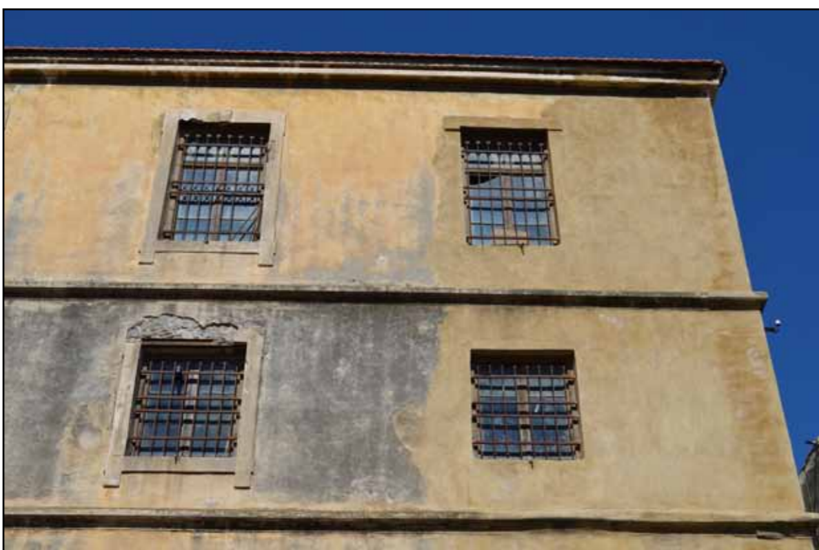
Πρόχειρη ανακατασκευή στη νότια όψη
