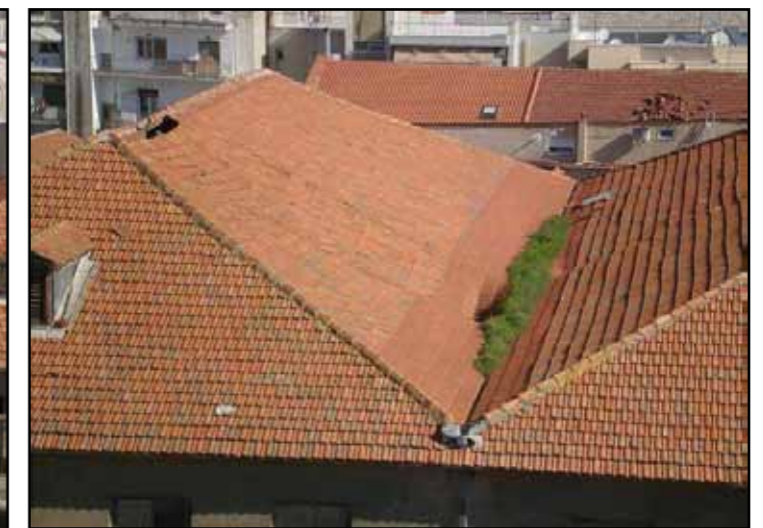
Καπναποθήκες ΣΕΚΕ - στέγη σε μοντέρνα κατασκευή
