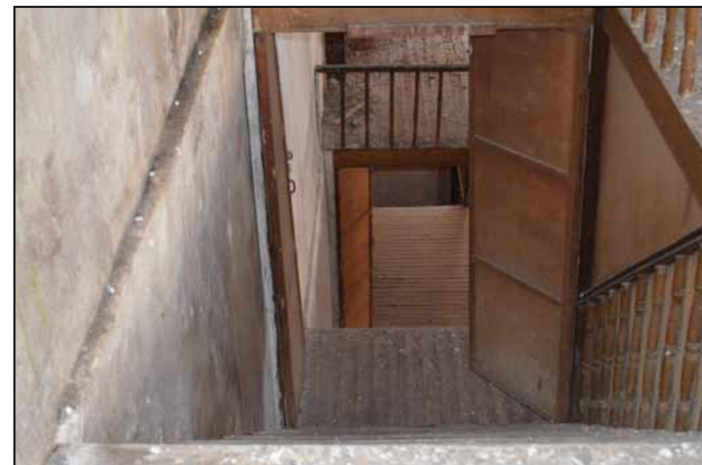
Η κλίμακα από τον τρίτο στον πρώτο όροφο [βόρειο σύστημα]
