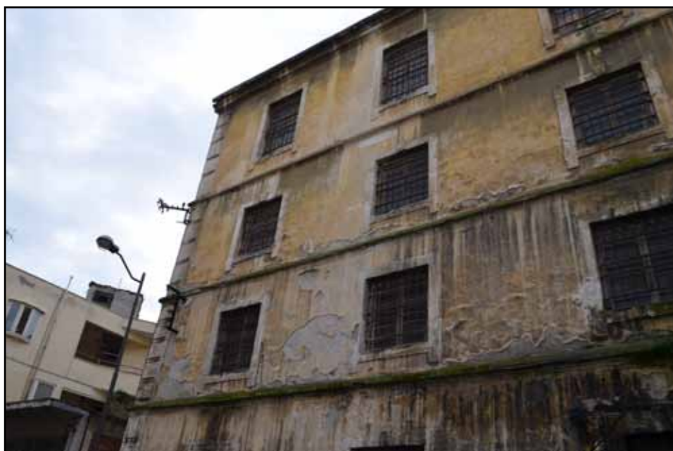
Βόρεια όψη - σε δυσμενέστερη κατάσταση από τις υπόλοιπες λόγω του προσανατολισμού της και της ανερχόμενης υγρασίας από την υπερύψωση της στάθμης του δρόμου
