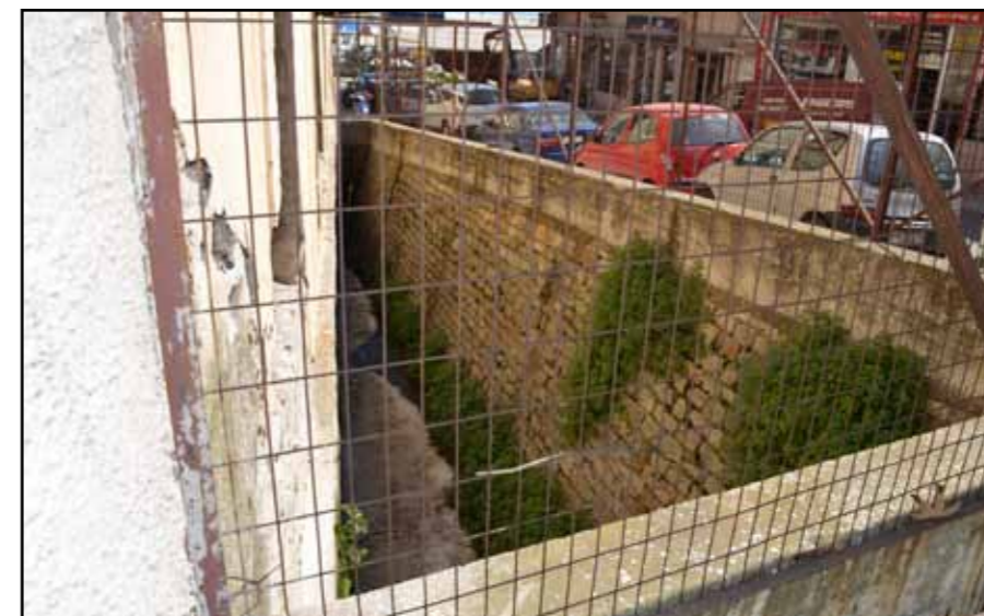
Αναληματικός τοίχος στη νότια όψη
