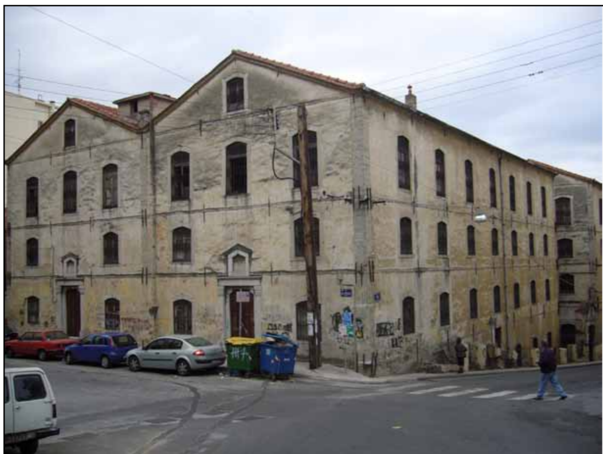
Καπναποθήκη Πετρίδη, οδός Δαγκλή
