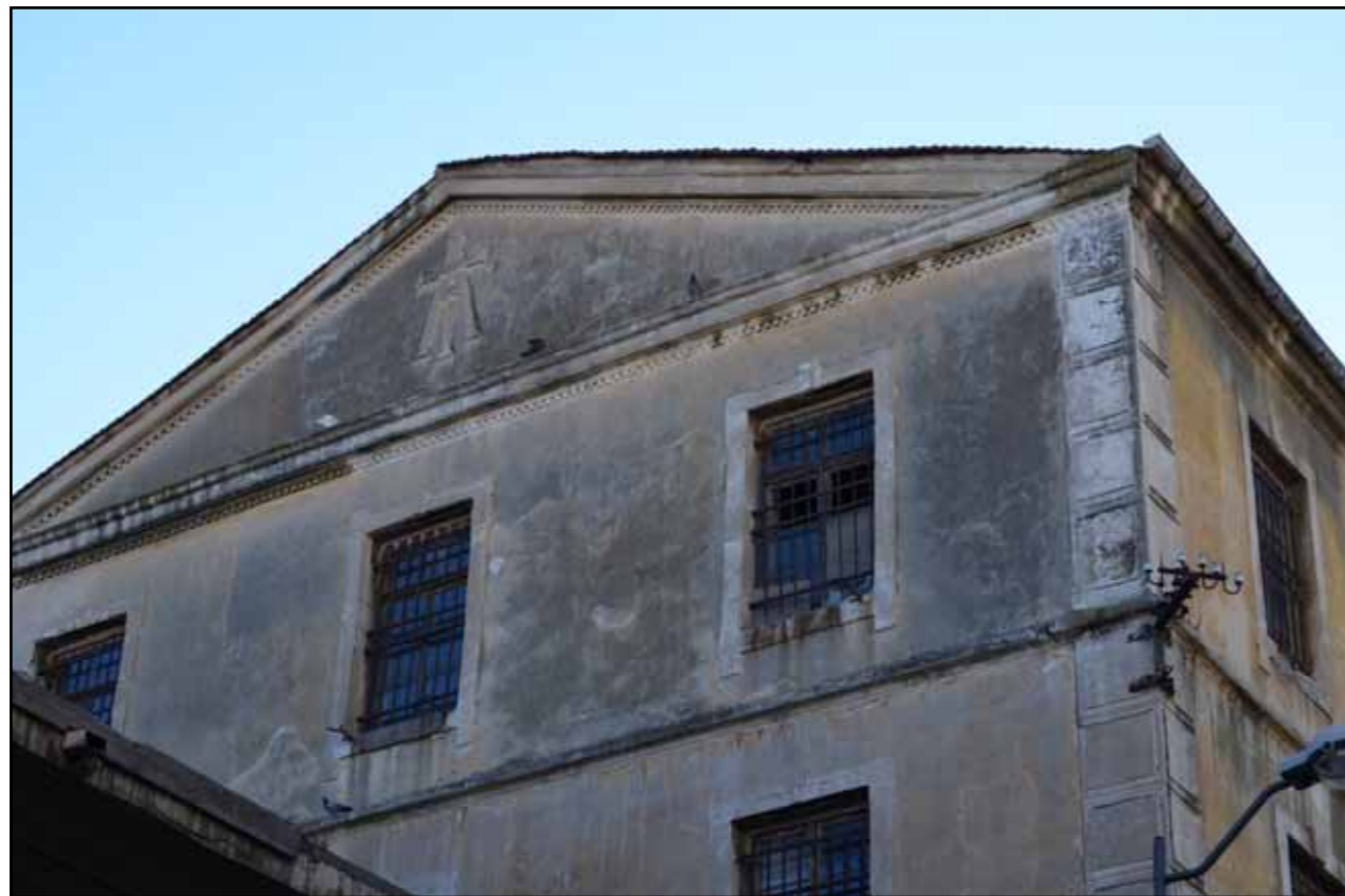
Ανατολική όψη - υγρασία, αποκολλήσεις, αποφλοιώσεις, επεμβάσεις
