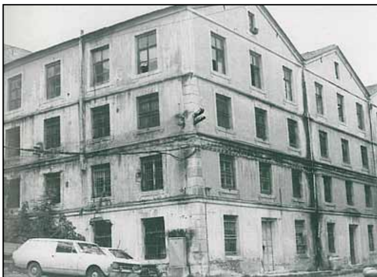
Καπναποθήκη στην πλατεία Ελευθερίας, επιχρισμένη, με διάκοσμο. Διακοσμήσεις - πλαισιώσεις στα ανοίγματα, οριζόντιες ζώνες που ορίζουν των πατωμάτα και κατακόρυφες ταινίες τον μεσότοιχο και τις γωνίες του κτιρίου [φώτ. 1986]
