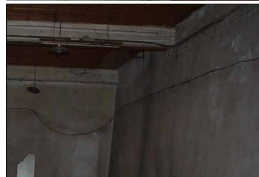
Μεταλλική λάμα δοκού στον μεσότοιχο
