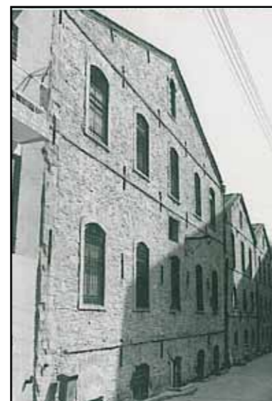
Τα αγκύρια εμφανή στις όψεις των καπναποθηκών. Μαρτυρούν εξωτερικά τον αριθμό των υποστυλωμάτων του κτιρίου
