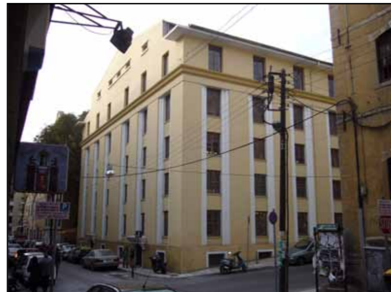
Πολυόροφη καπναποθήκη - νεότερο κτίριο της ύστερης περιόδου
