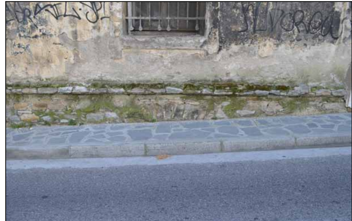
Τα ίχνη των ανοίγματος στο υπόγειο που έκλεισαν [εξωτερικά]
