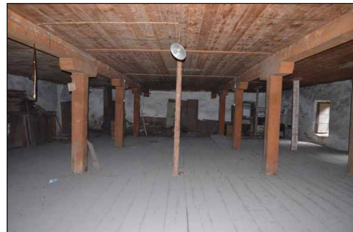
Διάταξη δοκών στο υπόγειο
