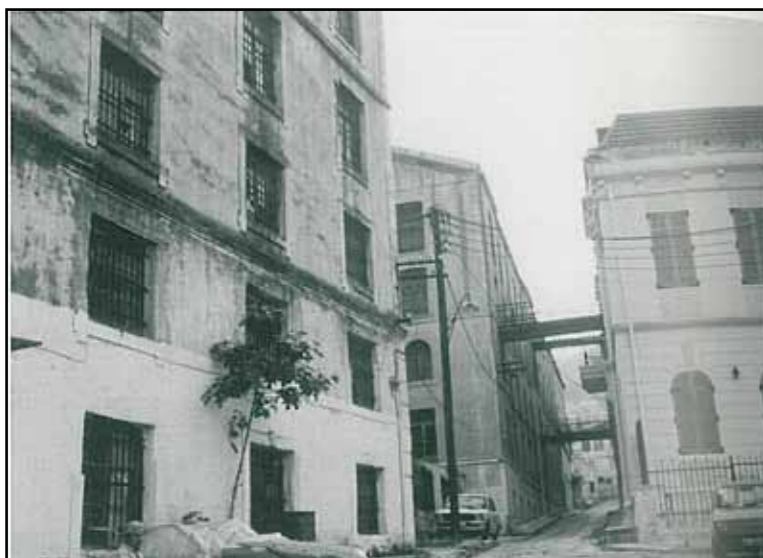
Καπναποθήκες στην πλατεία Ελευθερίας της Schinasi Bros - 1905, επιχρισμένες και με διακοσμητικές πλαισιώσεις στα ανοίγματα και οριζόντιες ταινίες [φώτ. 1986]
