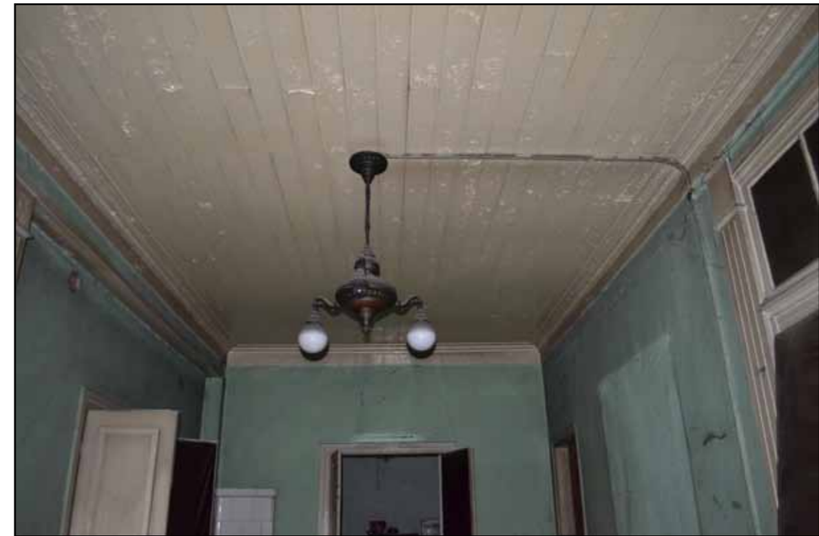
Οροφή χώρου γραφείων - διοίκησης [ισόγειο]
