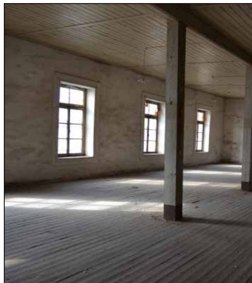
Τα συμμετρικά τοποθετημένα ανοίγματα εξασφάλιζαν ομοιόμορφο φωτισμό στο εσωτερικό, για τη διευκόλυνση των καπνεργατών κατά τα στάδια της χαρμανοποίησης και δεματοποίησης του καπνού
