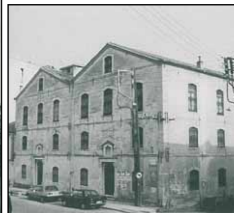
Τα αγκύρια εμφανή στις όψεις των καπναποθηκών. Μαρτυρούν εξωτερικά τον αριθμό των υποστυλωμάτων του κτιρίου
