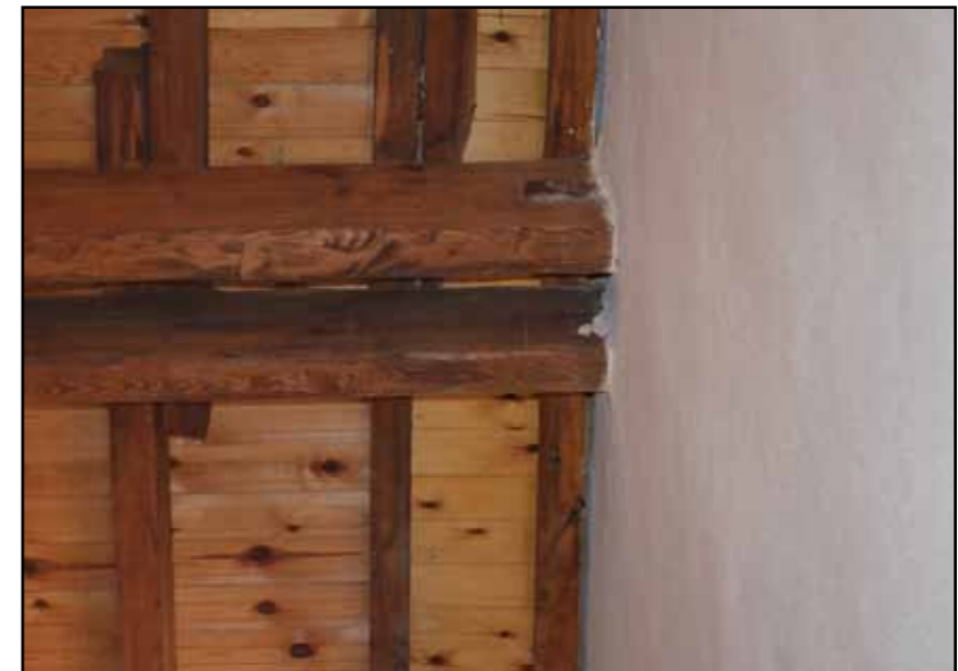
Δημοτική καπναποθήκη - κατασκευαστικό σύστημα. Σύστημα διπλής δίδυμης δοκού. Φαίνονται οι μεταλλικές λάμες, τόσο στο δέσιμο με την λιθοδομή, όσο και στην ένωση των δύο επιμέρους ξύλων της δοκού πάνω από τον στύλο [φωτο 2014]
