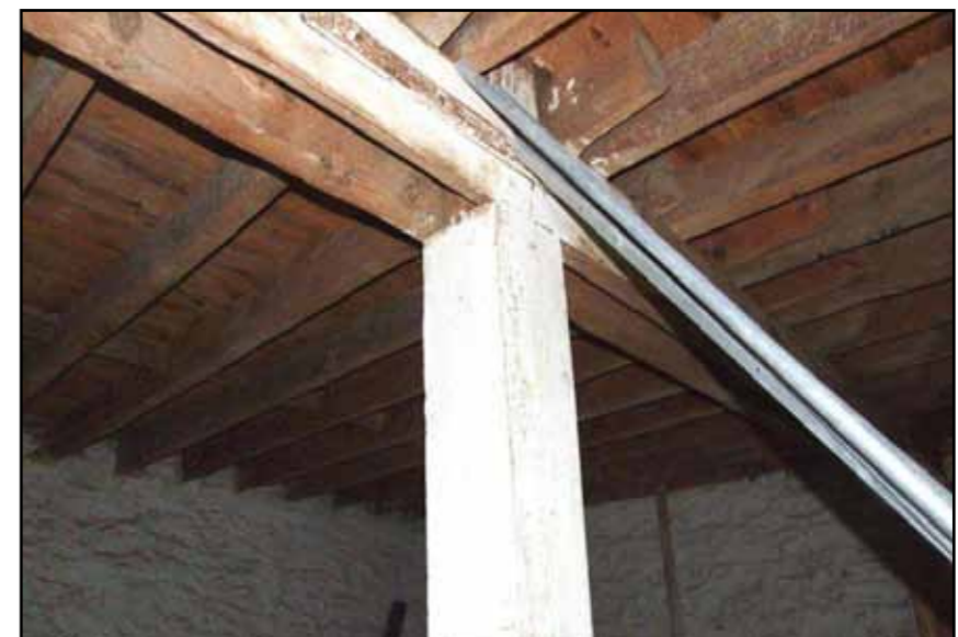
Δημοτική καπναποθήκη - κατασκευαστικό σύστημα. Σύστημα διπλής δίδυμης δοκού. Φαίνονται οι μεταλλικές λάμες, τόσο στο δέσιμο με την λιθοδομή, όσο και στην ένωση των δύο επιμέρους ξύλων της δοκού πάνω από τον στύλο [φωτο 2014]
