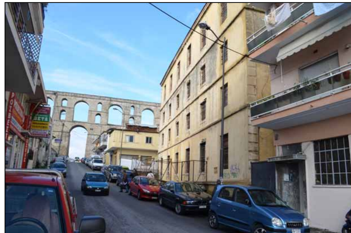
_Η βόρεια όψη της καπναποθήκης σήμερα. Άποψη της οδού Αμερικάνικου Ερυθρού Σταυρού. _Η νότια όψη της καπναποθήκης σήμερα. Άποψη της οδού Παλαιού Υδραγωγείου.
