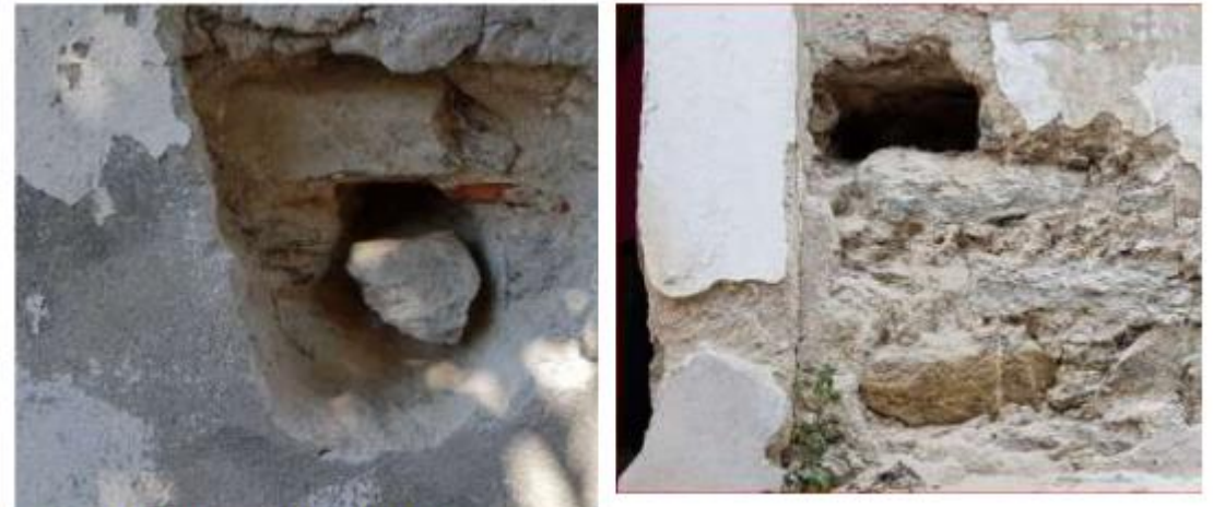
Εικόνα 14- Τυπικές τομές λιθοδομής
