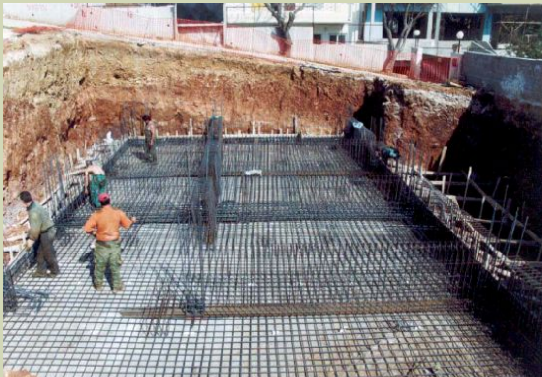
εικ.7: Διαδικασία κατασκευής γενικής κοιτόστρωσης.
