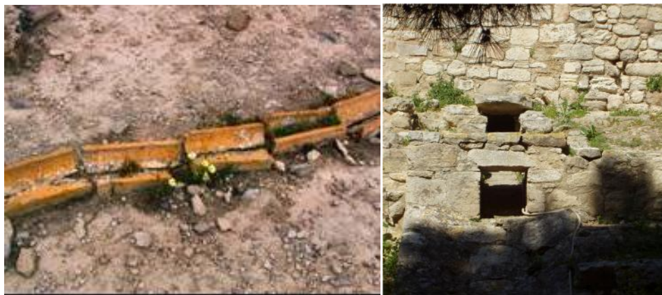
Σχήμα 1.2 Τμήματα του συστήματος αποχέτευσης στο ανάκτορο της Κνωσού: (αριστερά) πηλίνα καναλέτα εντός του ανακτόρου (πηγή: Angelakis et al, 2011) (δεξιά) έξοδος του κεντρικού αποχετευτικού αγωγού (πηγή: Αγγελάκης & Κουτσογιάννης, 2005).
