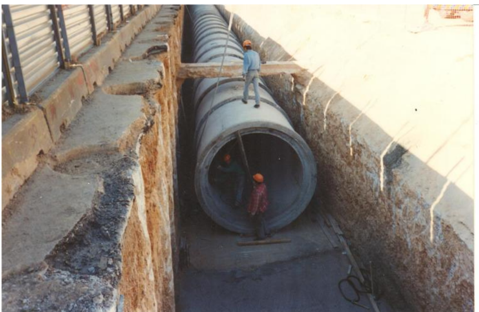
Σχήμα 7.2 Αγωγοί ομβρίων από σωλήνες από σκυρόδεμα διαμέτρου 2.5 m τοποθετημένοι στην Αθήνα (Λεωφόρος Μεσογείων).
