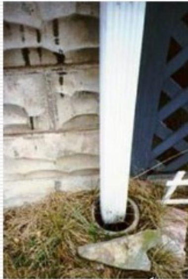
Παράνομη σύνδεση υδρορροής στο δίκτυο ακαθάρτων
