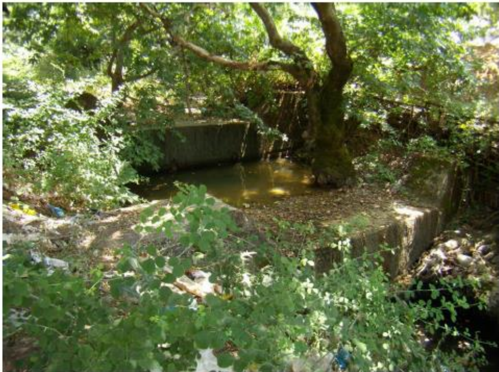
Εικόνα 5. Αναβαθμός από οπλισμένο σκυρόδεμα ( Πηγή: Κουλουκούρας, 2011)
