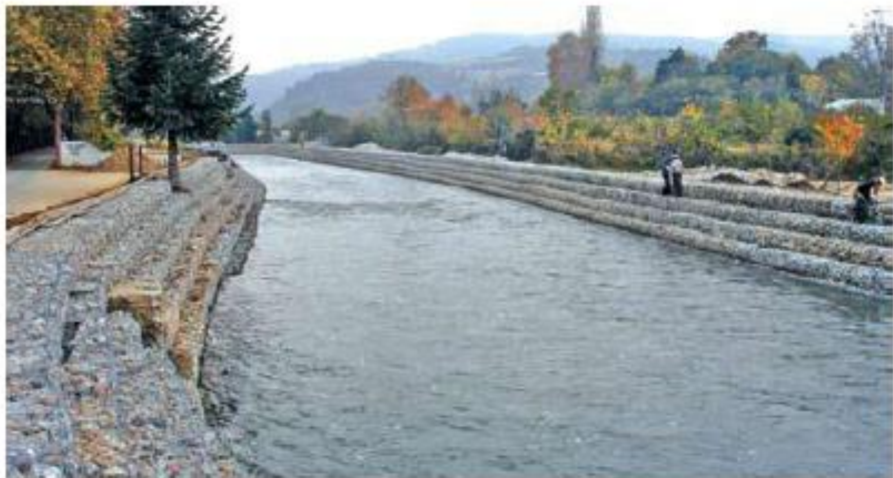
Εικόνα 7 . Συρματοκιβώτια στα πρανή χειμάρρου ( Πηγή: Κουλουκούρας, 2011)
