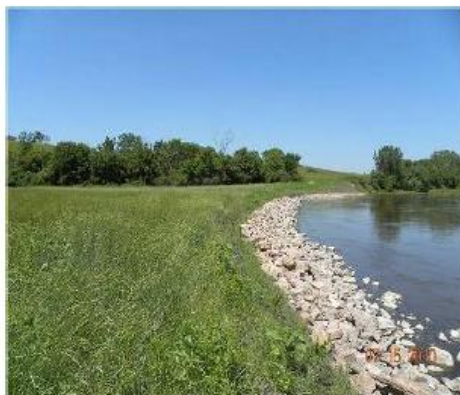
Εικόνα 2.4α) Ποταμός Big Sioux με διαβρωμένη παρόχθια ζώνη, Ιούνιος 2009 β) Παρόχθια ζώνη ποταμού Big Sioux με τοποθέτηση πετρών και βλάστησης στην παρόχθια περιοχή για την αντιμετώπιση της διάβρωσης, Ιούλιος 2010 (Πηγή: East Dakota Water Development District)
