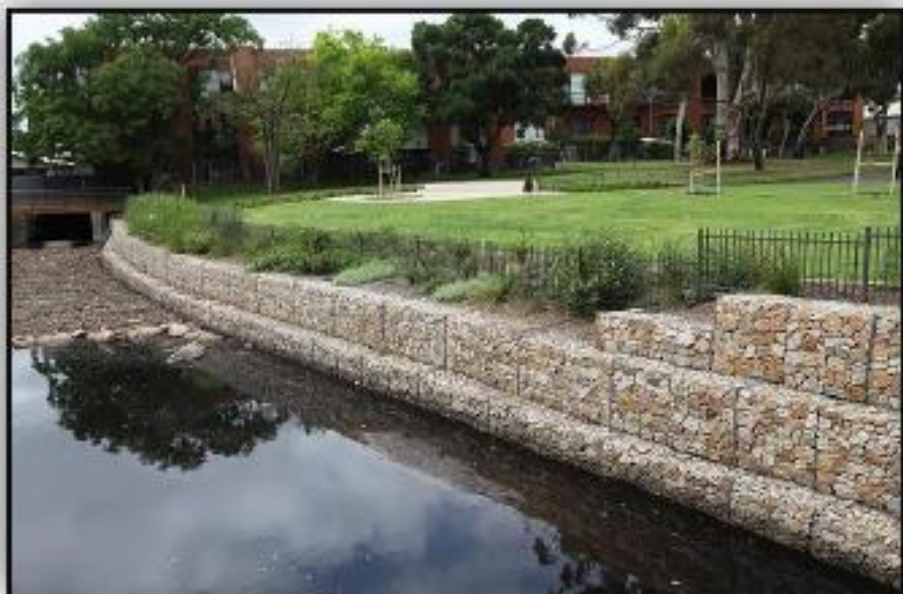
Εικόνα 2.11: α) Εφαρμογή συρμάτινων κιβωτίων σε ρυάκι στο Torrens Park, Αυστραλία
