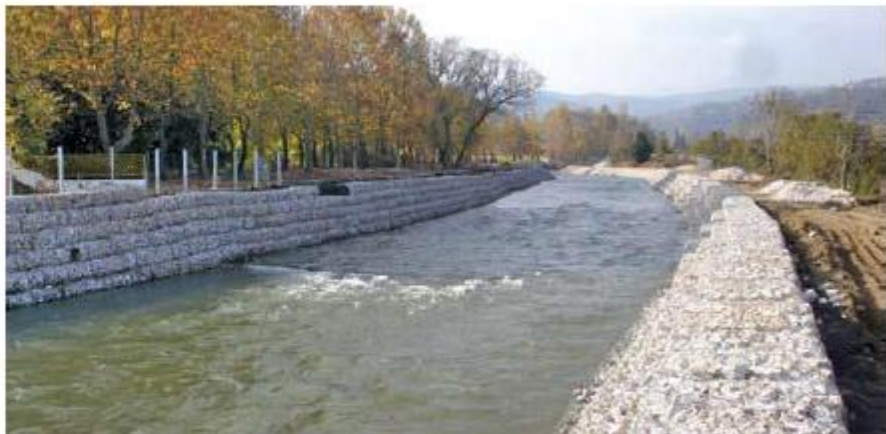
Εικόνα 8. Χείμαρρος μετά από έργα διευθέτησης και την τοποθέτηση συρματοκιβωτίων στα πρανή ( Πηγή: Κουλουκούρας, 2011)
