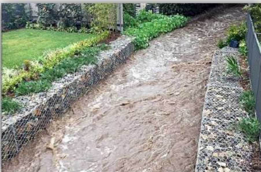
β) Εφαρμογή συρμάτινων κιβωτίων σε ρυάκι στο Steerney, Αυστραλία (Πηγή: Prospect Contactors PTY LTD)
