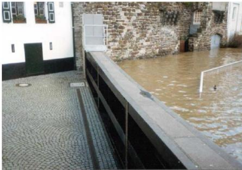
Κατασκευαστικά μέτρα Θυροφράγματα για πλημμυρικά νερά
