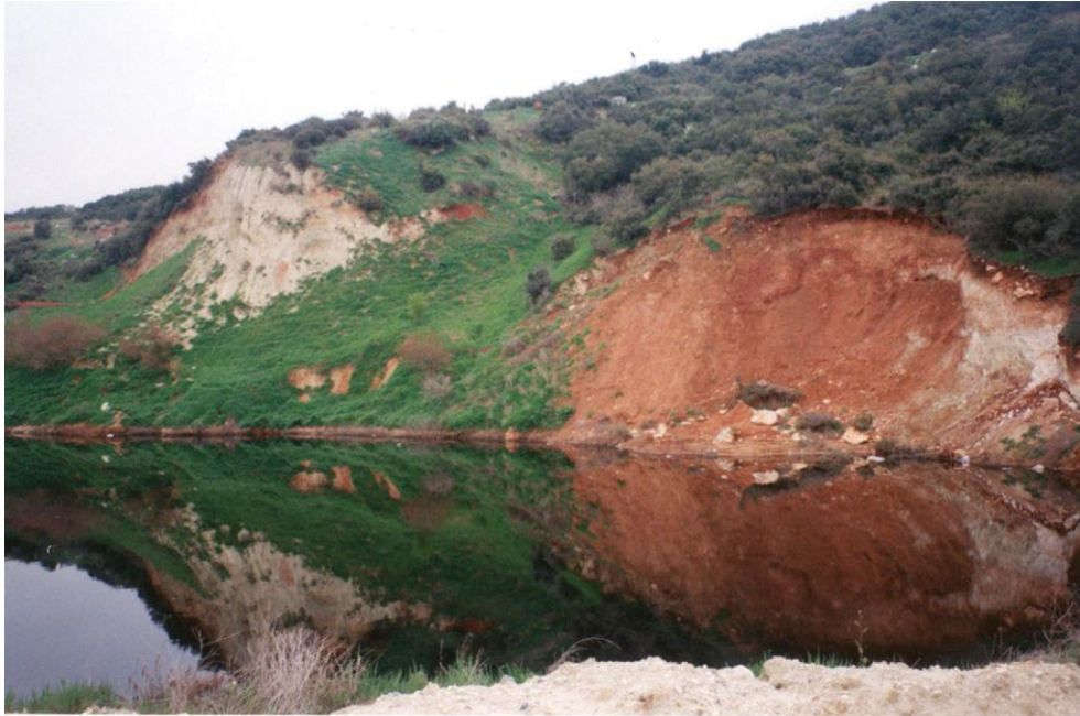
Λιμνοδεξαμενή συλλογής διασταλαζόντων στον ΧΥΤΑ Ταγαράδων.
