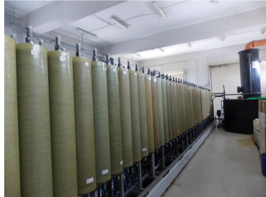
Προχωρημένη επεξεργασία με αντίστροφη ώσμωση διασταλαζόντων στον ΧΥΤΑ Μαυροράχης.
