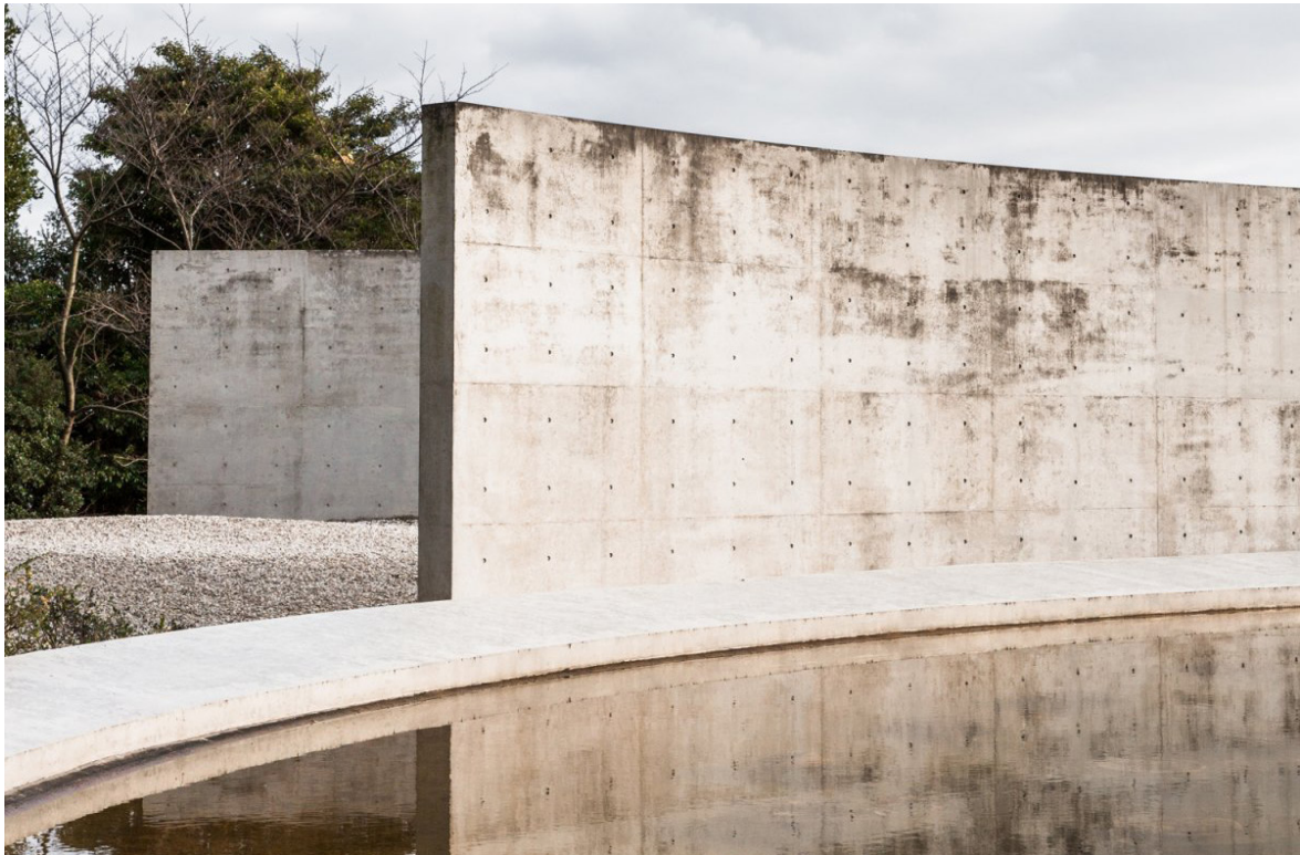
Εικόνα 160: Υγρο στοιχείο και Σκυρόδεμα.
