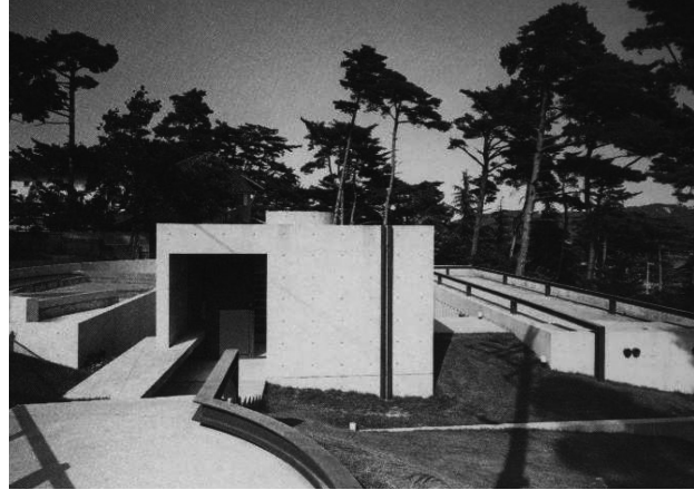
Εικόνα 105: Είσοδος στο Κτίριο.
