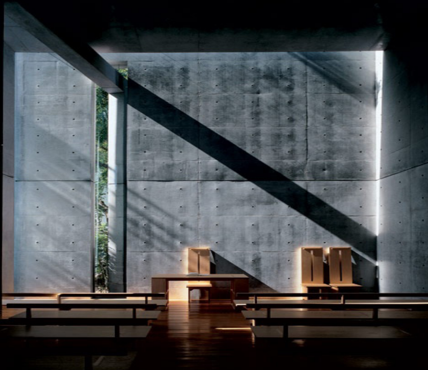
Εικόνα 61: Εμφανές Σκυρόδεμα στο Church of the Light
