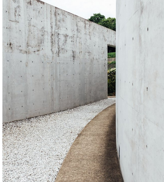
Εικόνα 159: Καμπυλωτός τοίχος από σκυρόδεμα.
