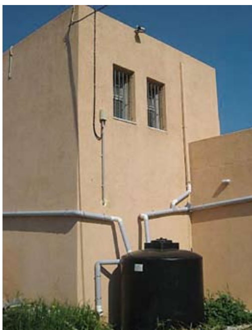
> Δεξαμενή συλλογής βρόχινου νερού στο Κατάστημα της Τράπεζας Πειραιώς στην Τζια (Κέα)
