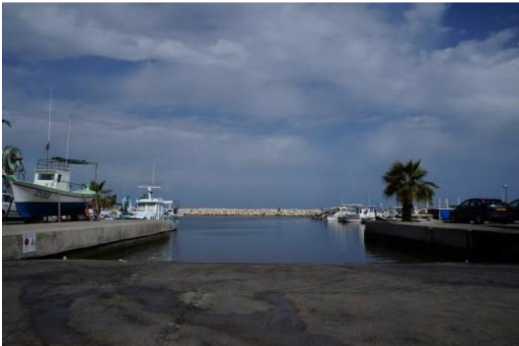
Ράμπες ανέλκυσης/καθέλκυσης σκαφών
