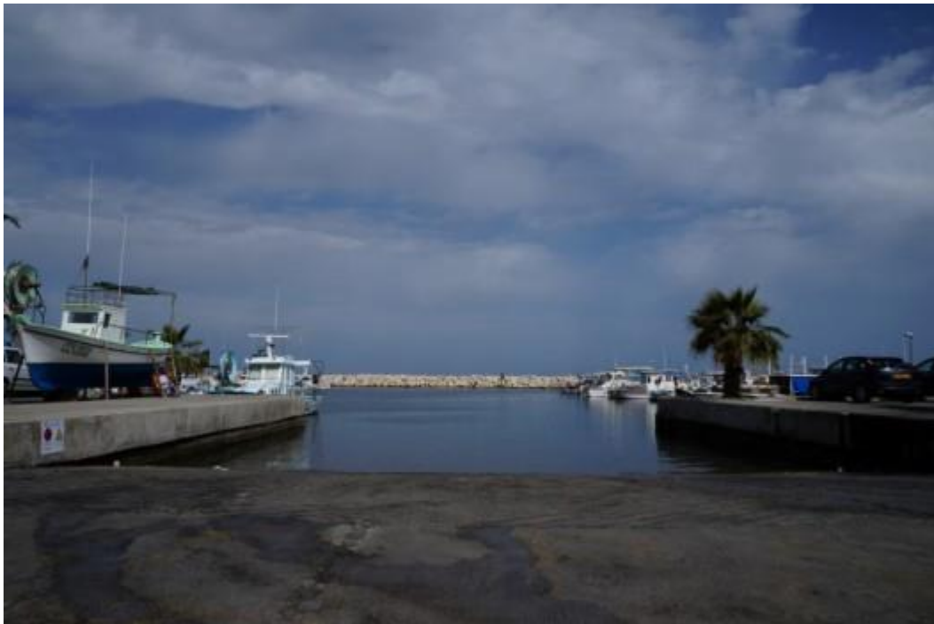
Ράμπες ανέλκυσης/καθέλκυσης σκαφών
