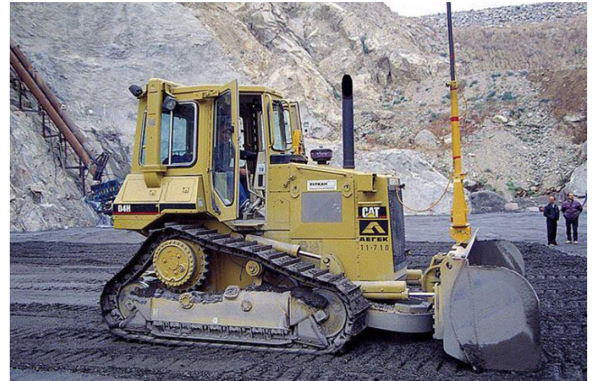
Διάστρωση RCC
