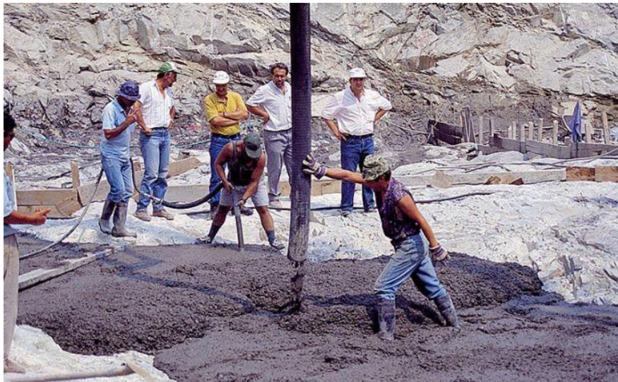
Σκυροδέτηση στρώσης θεμελίωσης
