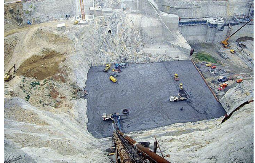
Κατασκευή στρώσης RCC
