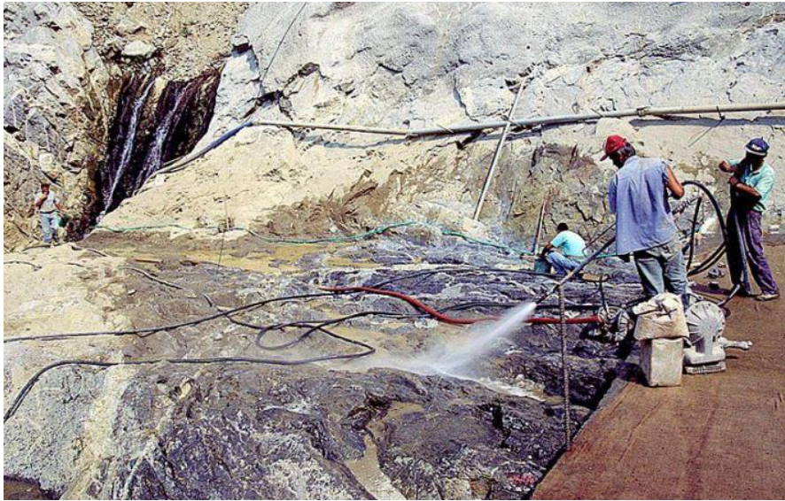
Καθαρισμός θεμελίωσης με νερό και πεπιεσμένο αέρα
