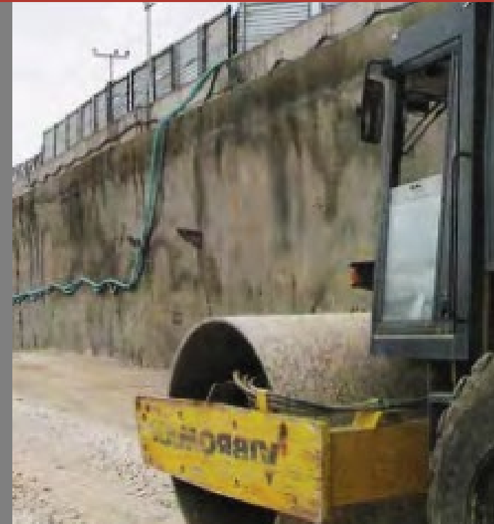
Συμπύκνωση με οδοστρωτήρα
