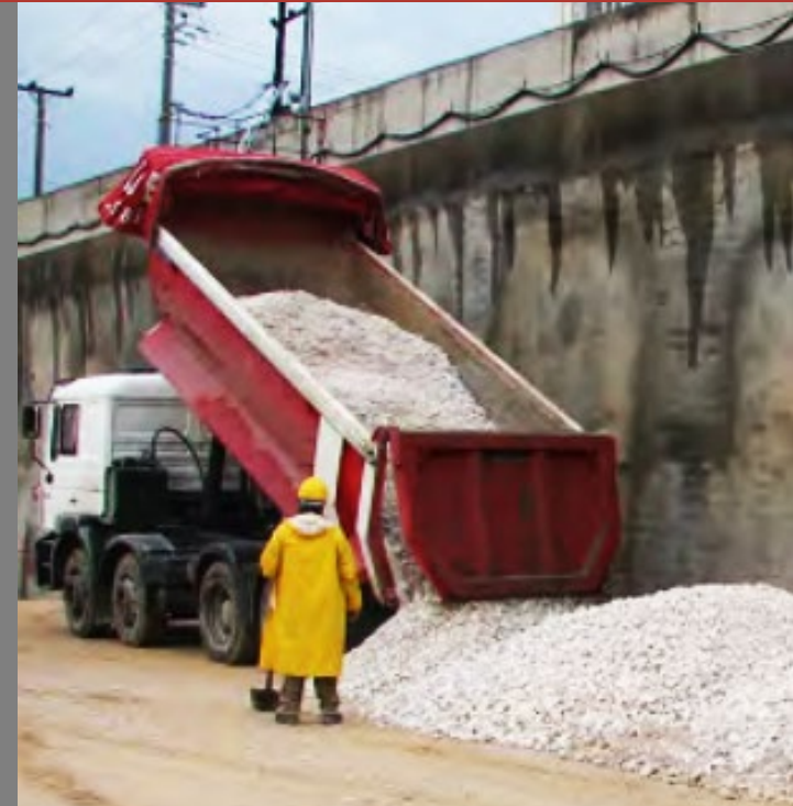
Εκφόρτωση αμμοχάλικου σε σωρούς μπροστά από το μέτωπο προώθησης
