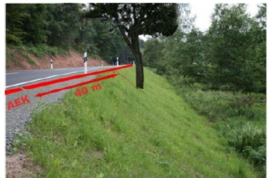
Σχ. Π5-3: Επικίνδυνη θέση σε πρανές επιχώματος (ισχύει όταν δεν απαιτείται ΣΑΟ λόγω του πρανούς) όπου μπορεί να εφαρμοστεί το ενιαίο μήκος ΣΑΟ ίσο με 40 μέτρα πριν το εμπόδιο
