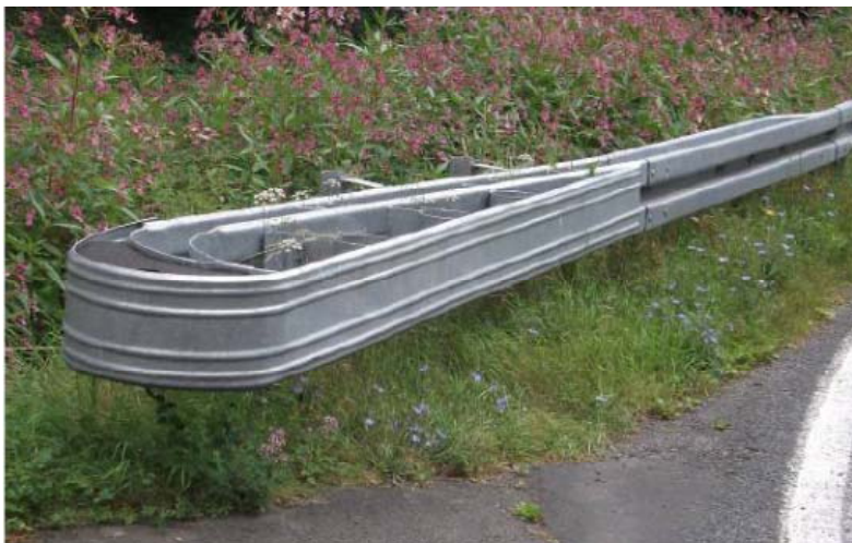
Σχ. Π11-2: Πιστοποιημένη μη καταβιβασμένη απόληξη στηθαίου.
