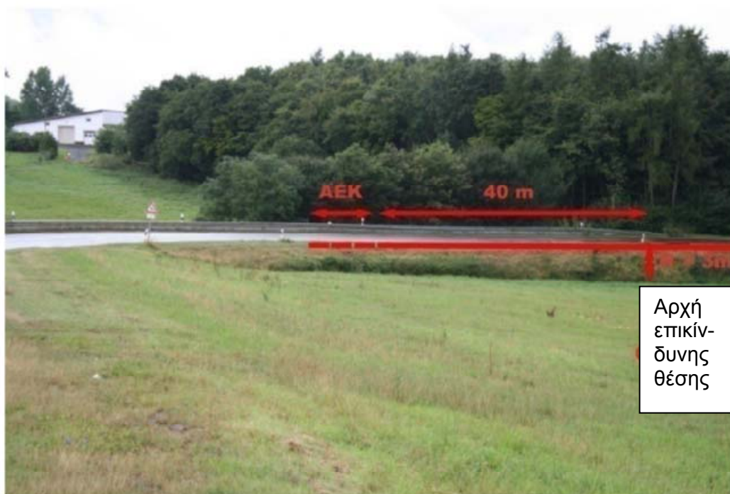
Σχ. Π5-1: Επικίνδυνη θέση (εμπόδιο) σε πρηνές επιχώματος όπου μπορεί να εφαρμοστεί το ενιαίο μήκος ΣΑΟ ίσο με 40m πριν το εμπόδιο
