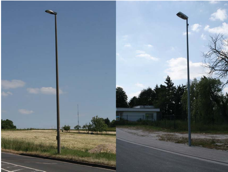
Συμπαγής ιστός οδοφωτισμού ⇒ Κατηγορία κινδύνου 3
