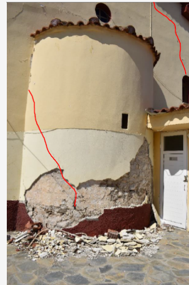
Εκτός επιπέδου ρηγματώσεις λιθοδομής ιερού. Εκτεταμένη αποδιοργάνωση λιθωμάτων – κονιάματος στη βάση του και μέχρι ύψους 1μ λόγω κάμψης (καμπτική ρηγματώση).
