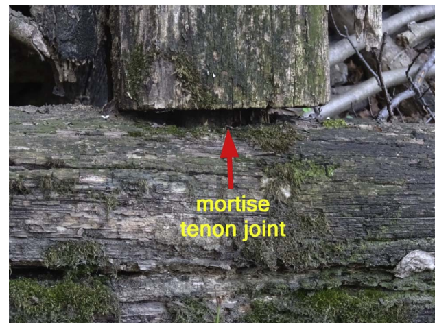
Fig. 21. Mortise tenon connection.
