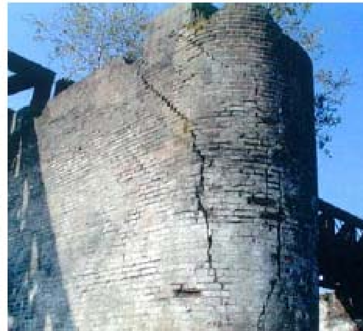
Ρηγμάτωση τοιχοποιίας
