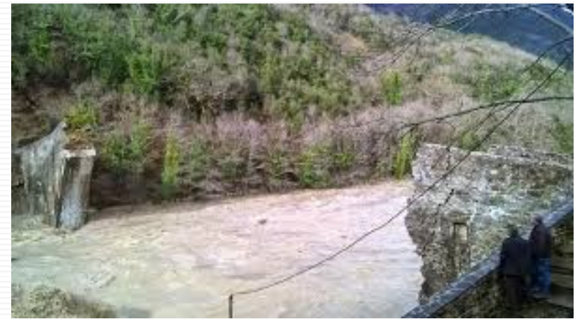
Κατάρρευση λόγω βροχόπτωσης, 2015 Υποσκαφή θεμελίωσης
