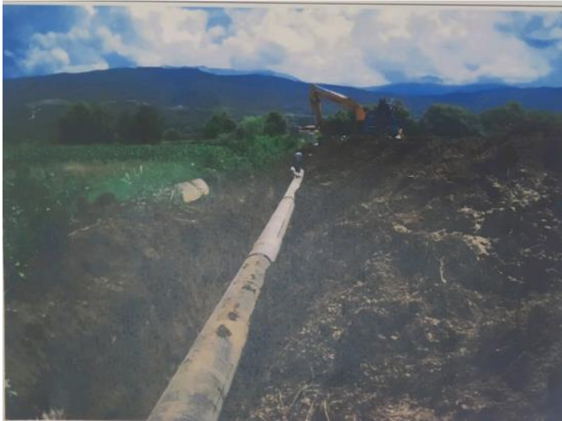
Εικόνα 3-22: Κατασκευή αρδευτικού δικτύου
