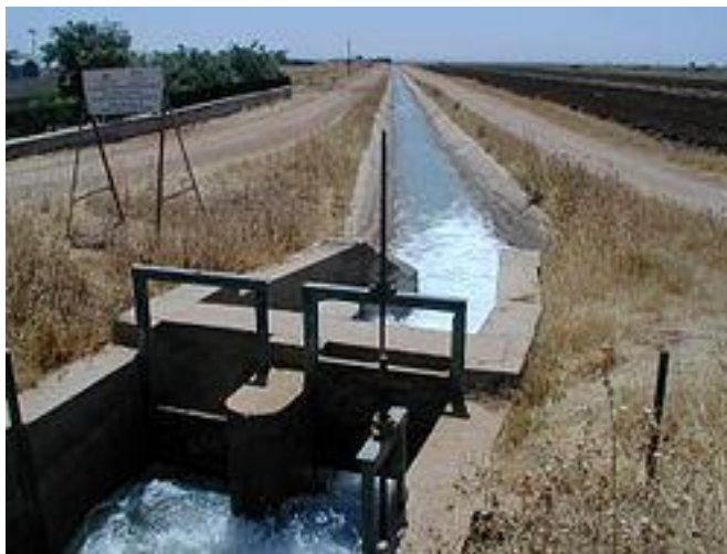
Εικόνα 1-3 Τμήμα Επιφανειακού αρδευτικού δικτύου με ανοικτές διώρυγες (πηγή: https://el.wikipedia.org/wiki/Αρδευση )
