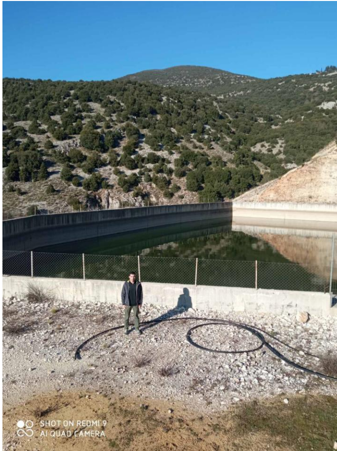
Εικόνα 3-24: Δεξαμενή Π1 περιοχής Πόρου
