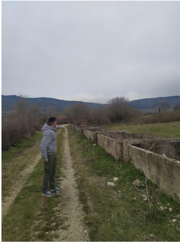
Εικόνα 3-1: Διώρυγα ανοικτού αγωγού του προγενέστερου αρδευτικού δικτύου της περιοχής που παρέμεινε μετά την αποξήλωση του μεγαλύτερου κομματιού του παλιού έργου
