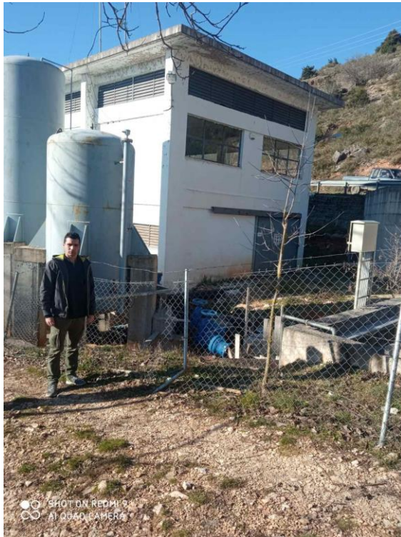
Εικόνα 3-27: Στα αντλιοστάσια Α1 και Α2 της περιοχής Πόρου
