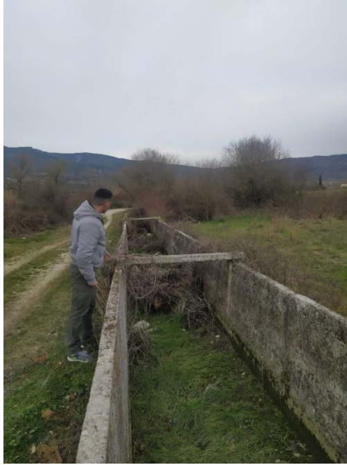
Εικόνα 3-2: Εσωτερικό μέρος διώρυγας προγενέστερου αρδευτικού δικτύου περιοχής Πόρου που παρέμεινε μετά την αποξήλωση του έργου
