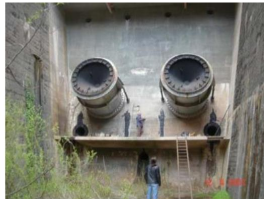
Έξοδος εκκενωτή φράγματος Ταυρωπού
