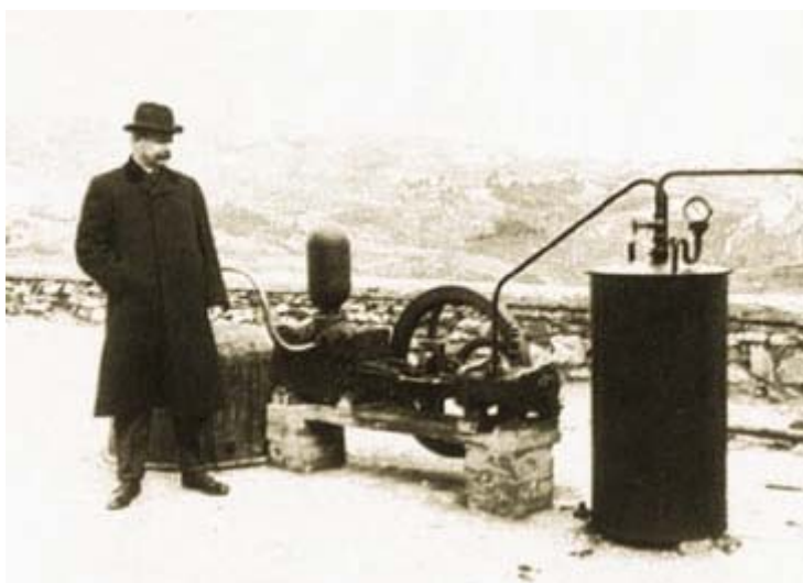
Σχήμα 3. Η μηχανή που χρησιμοποιήθηκε στο Larderello το 1904 κατά την πρώτη πειραματική απόπειρα παραγωγής ηλεκτρικής ενέργειας από γεωθερμικό ατμό. Διακρίνεται επίσης ο εφευρέτης της, πρίγκηπας Piero Ginori Conti.
