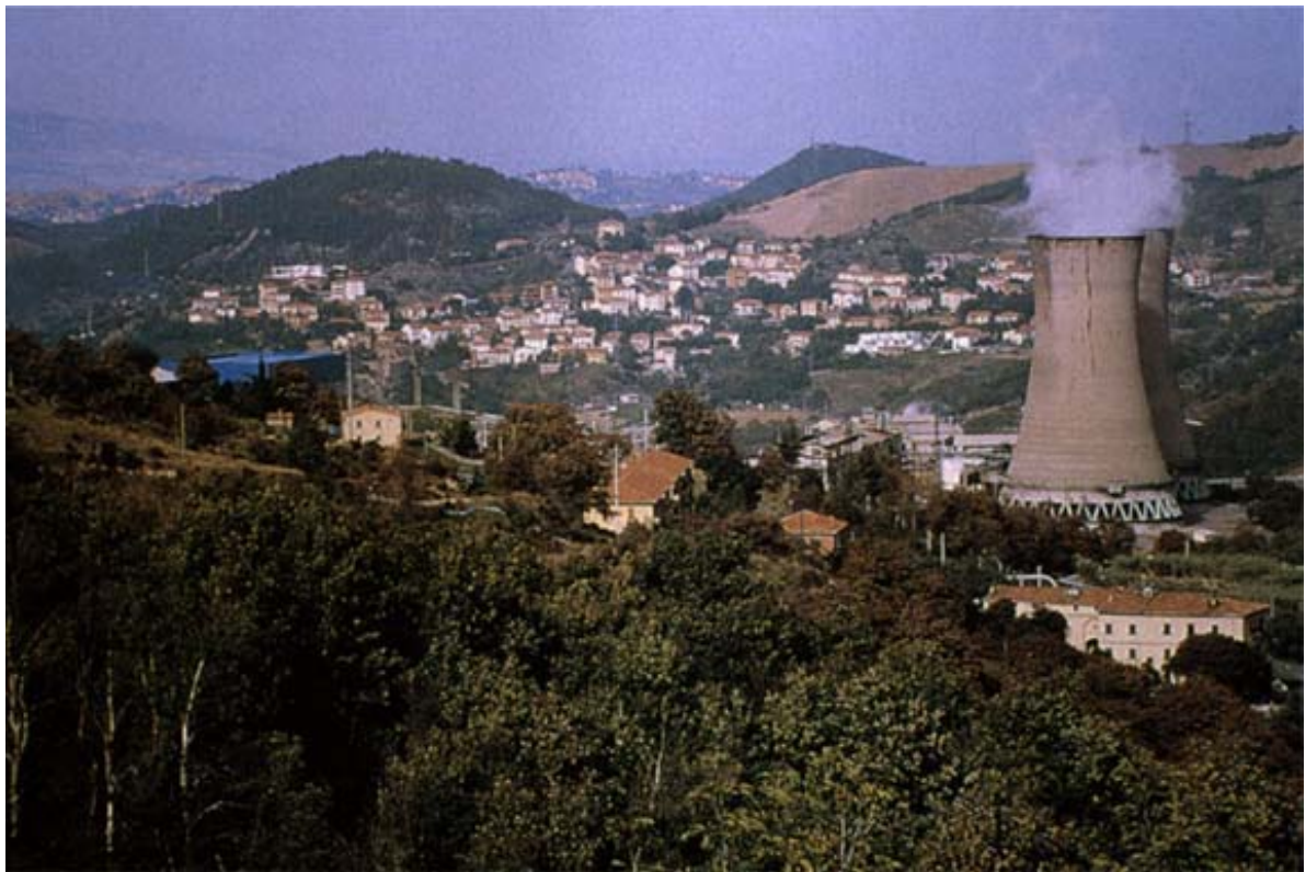
Μονάδα παραγωγής ηλεκτρικής ενέργειας στο Larderello της Ιταλίας [Πηγή: Geothermal Education Office, www.geothermal.marin.org ]
