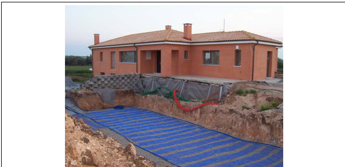
Χρήση συστήματος γεωθερμικής αντλίας θερμότητας (τοποθέτηση οριζόντιο κλειστού κυκλώματος γεωεναλλάκτη) για την κάλυψη θερμικών αναγκών μονοκατοικίας 220 m 2 στην περιοχή Αγγελοχωρίου Θεσ/νίκης (στάδιο κατασκευής και ανάπτυξης)
