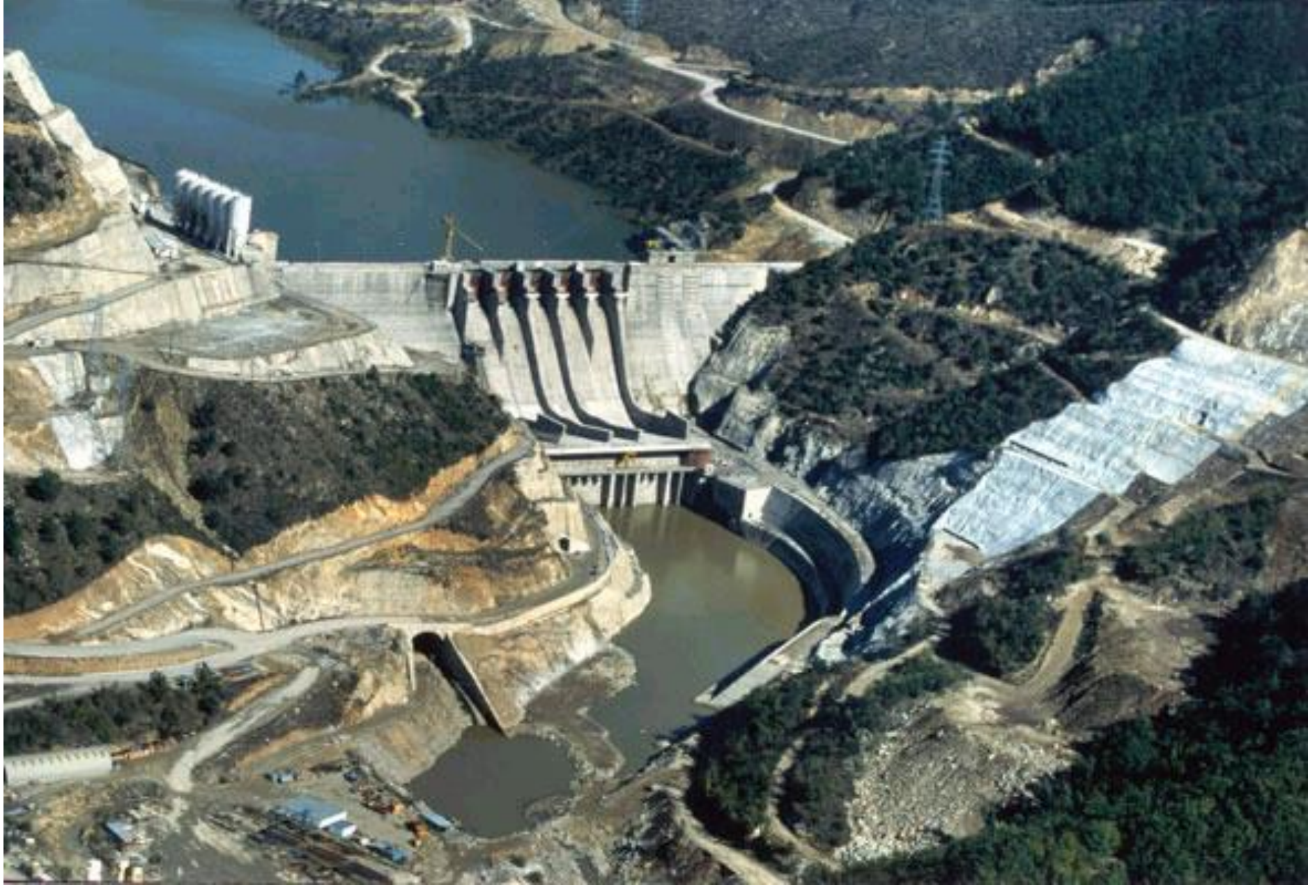
ΥΗΣ Πλατανόβρυσης στον ποταμό Νέστο. Δράμα, Μακεδονία 2 μονάδες συνολικής ισχύος 100 MW. Αντλήσεως – ταμιεύσεως
