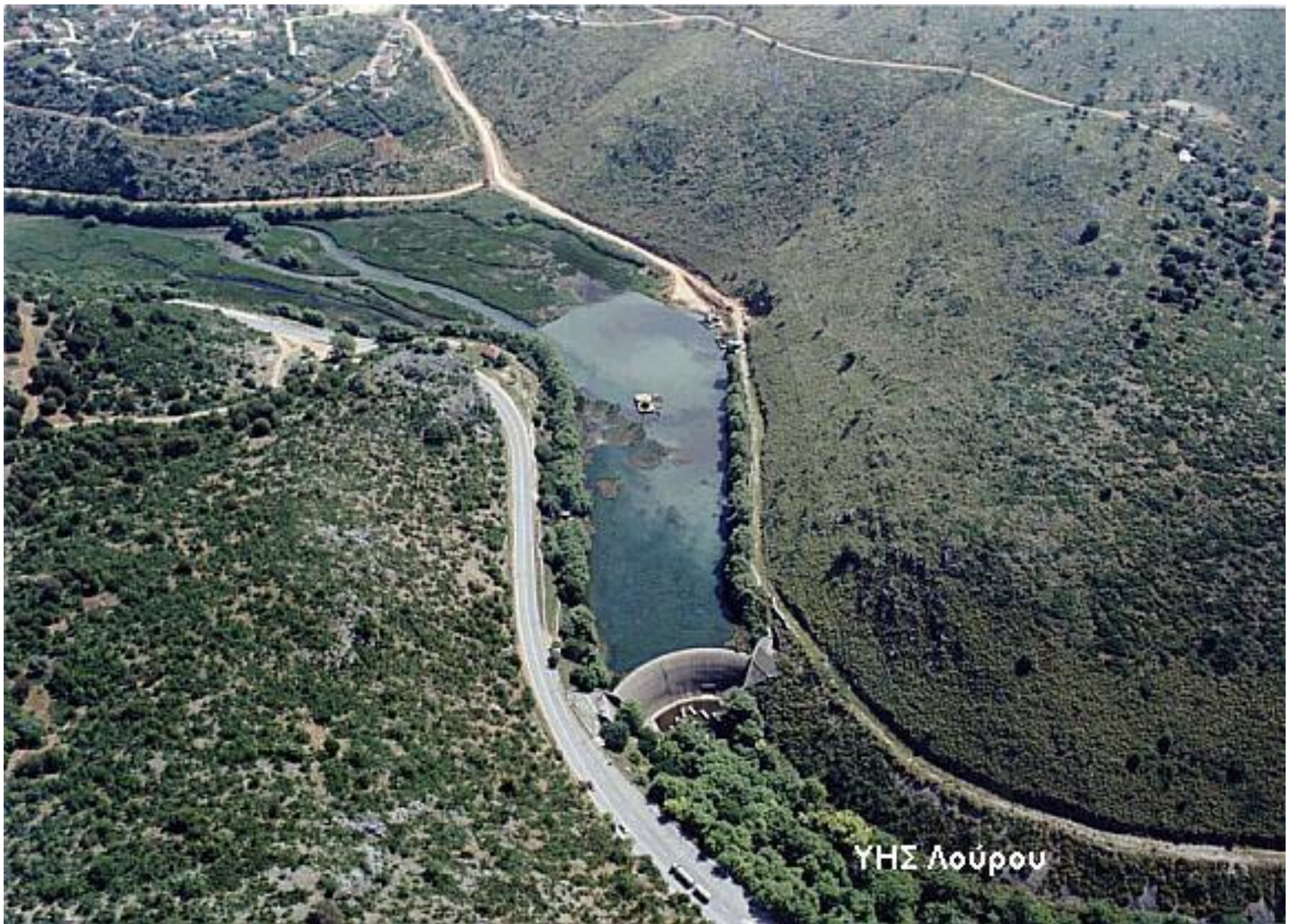
YHS Λούρου, Φιλιππιάδα, Ηπειρος. 3 μονάδες συνολικής ισχύος 10,3 MW
