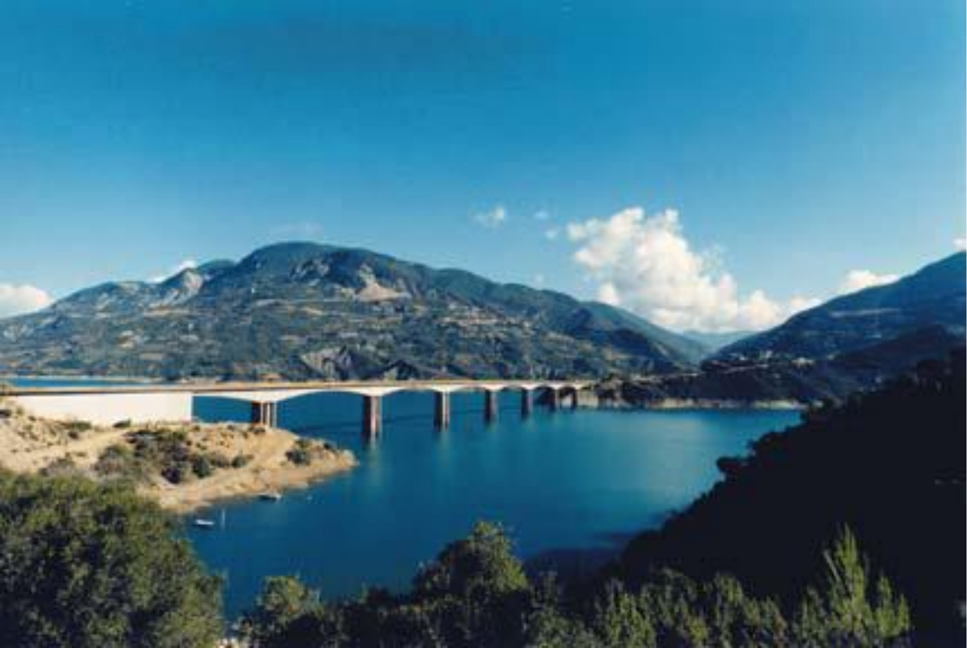
Άποψη ταμιευτήρα ΥΗΣ Κρεμαστών
