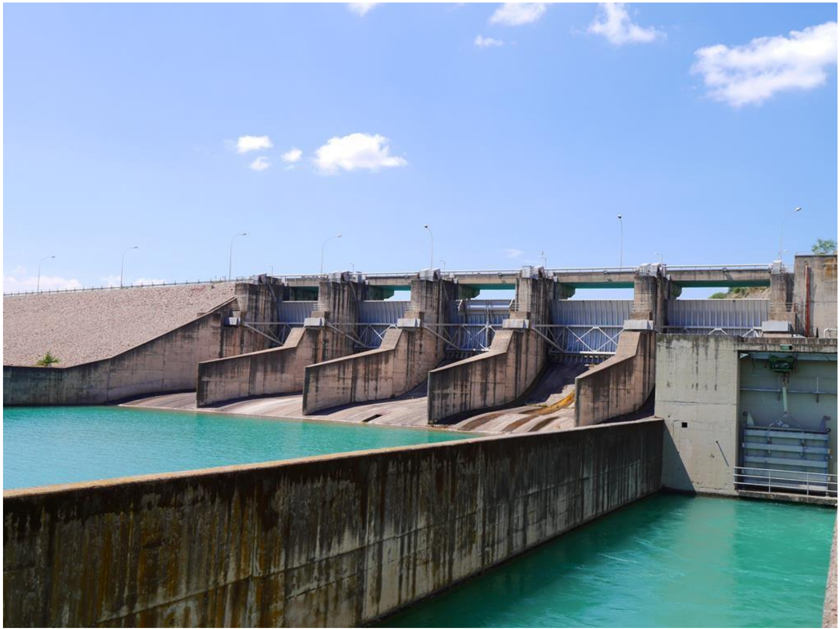
ΥΗΣ Λούρου, Φιλιππιάδα, Ηπειρος. 3 μονάδες συνολικής ισχύος 10,3 MW
