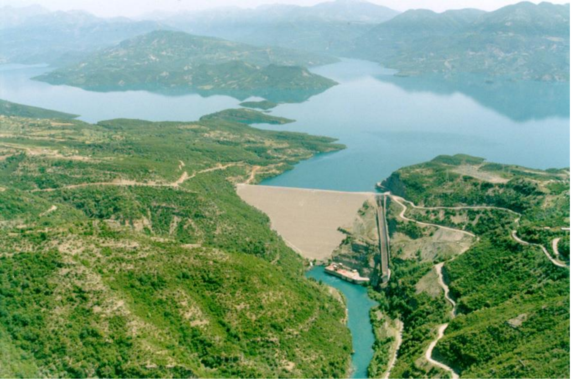
Άποψη φράγματος & ταμιευτήρα ΥΗΣ Κρεμαστών
