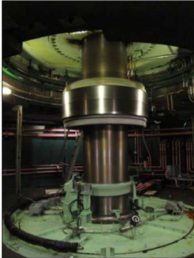
Εικόνα 17: Γεννήτρια κατακόρυφου τύπου του ΥΗΣ
