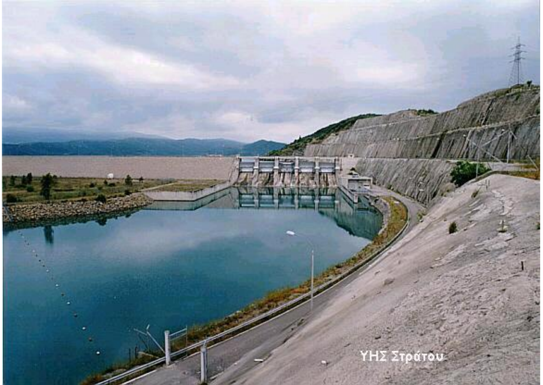
YHS Στράτου Αγρίνιο, Κεντρ. Ελλάδα. 4 μονάδες συνολικής ισχύος 156,2 MW
