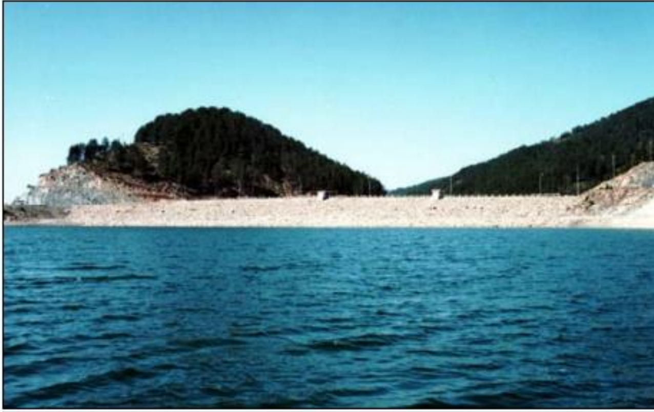
Εικόνα 2: Το κύριο φράγμα του ΥΣ όπως φαίνεται μέσα από τη λίμνη (Πηγή: Δ/νση ΥΗΣ Πηγών Αώου)
