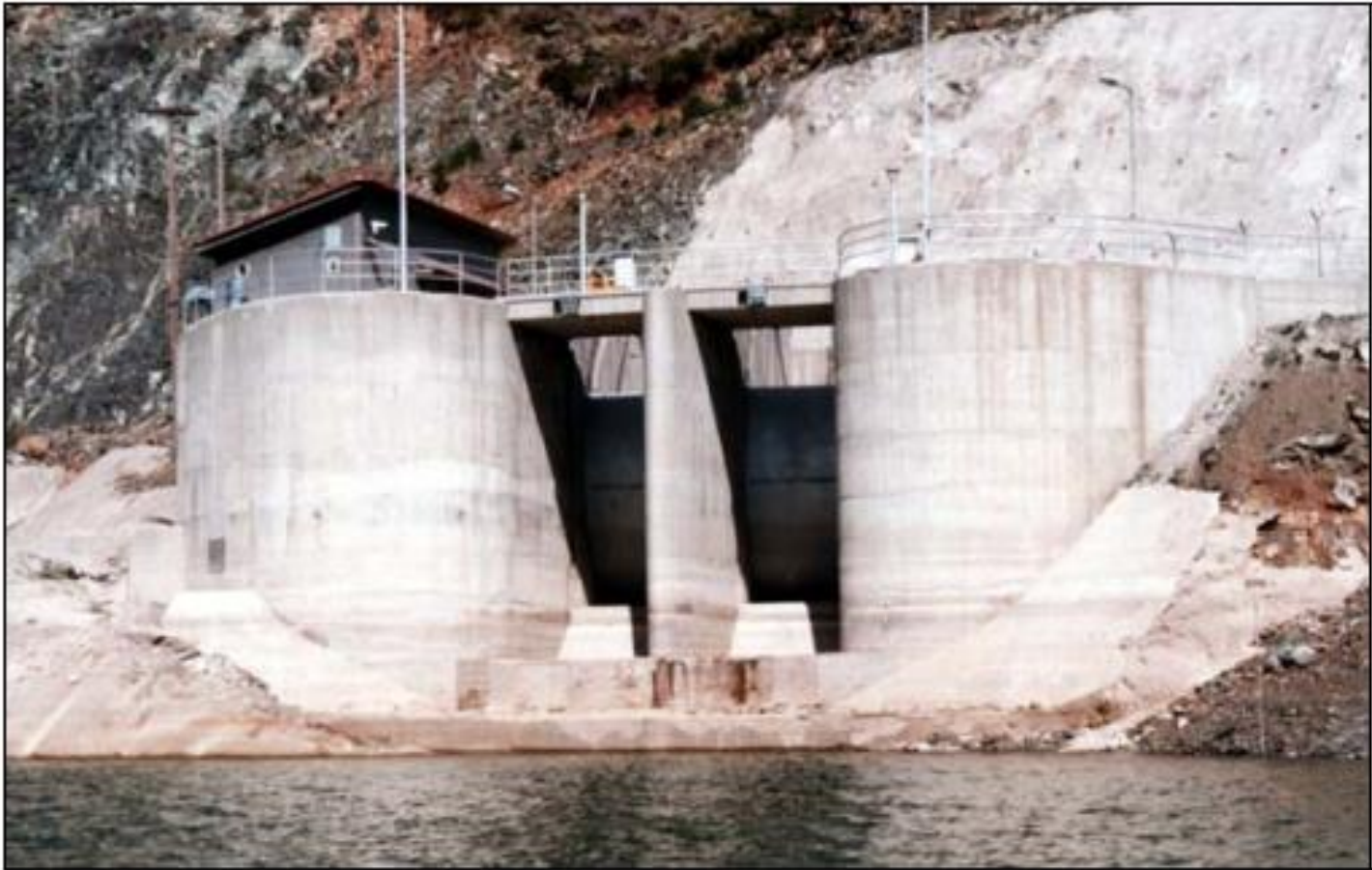
Εικόνα 6: Τα θυροφράγματα του εκχειλιστή όπως φαίνονται μέσα από την λίμνη (Πηγή: Δ/νση ΥΗΣ Πηγών Αώου)
