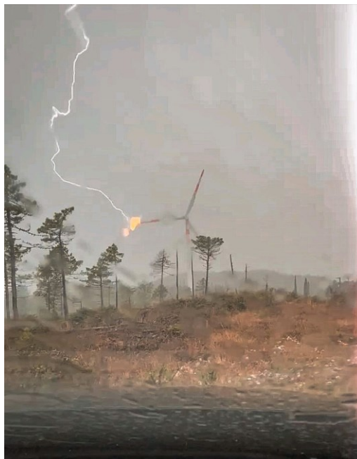
Σχήμα 1.2: Κεραυνικό πλήγμα σε ανεμογεννήτρια
