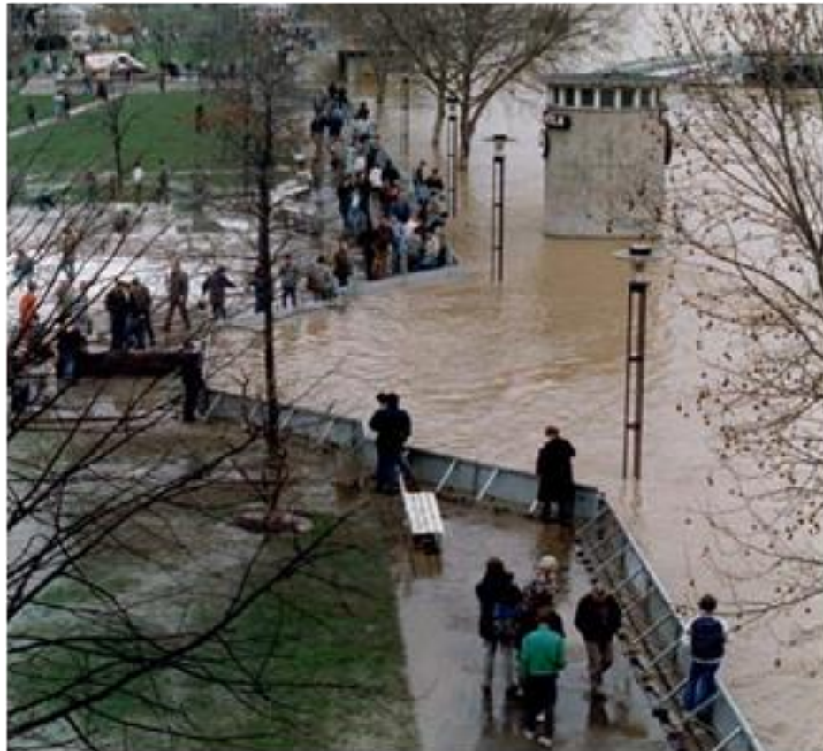
Κατασκευή προστατευτικών τοιχίων
