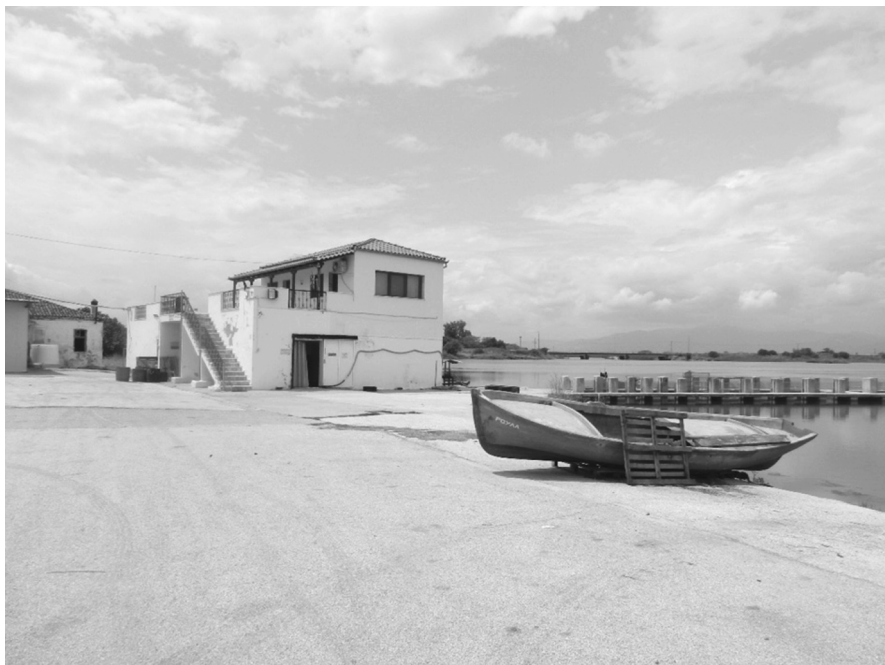
Φωτ. 4. Το κτήριο του συνεταιρισμού και εργασιακοί χώροι στη Βιστωνίδα, 2019
